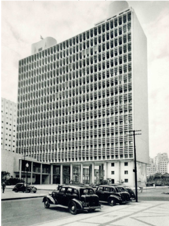
Figura 14 - Antigo Ministério da Educação e Saúde, Rio de Janeiro, hoje Palácio Capanema, projeto de 1938 (coordenado pelo arquiteto brasileiro Lúcio Costa)
