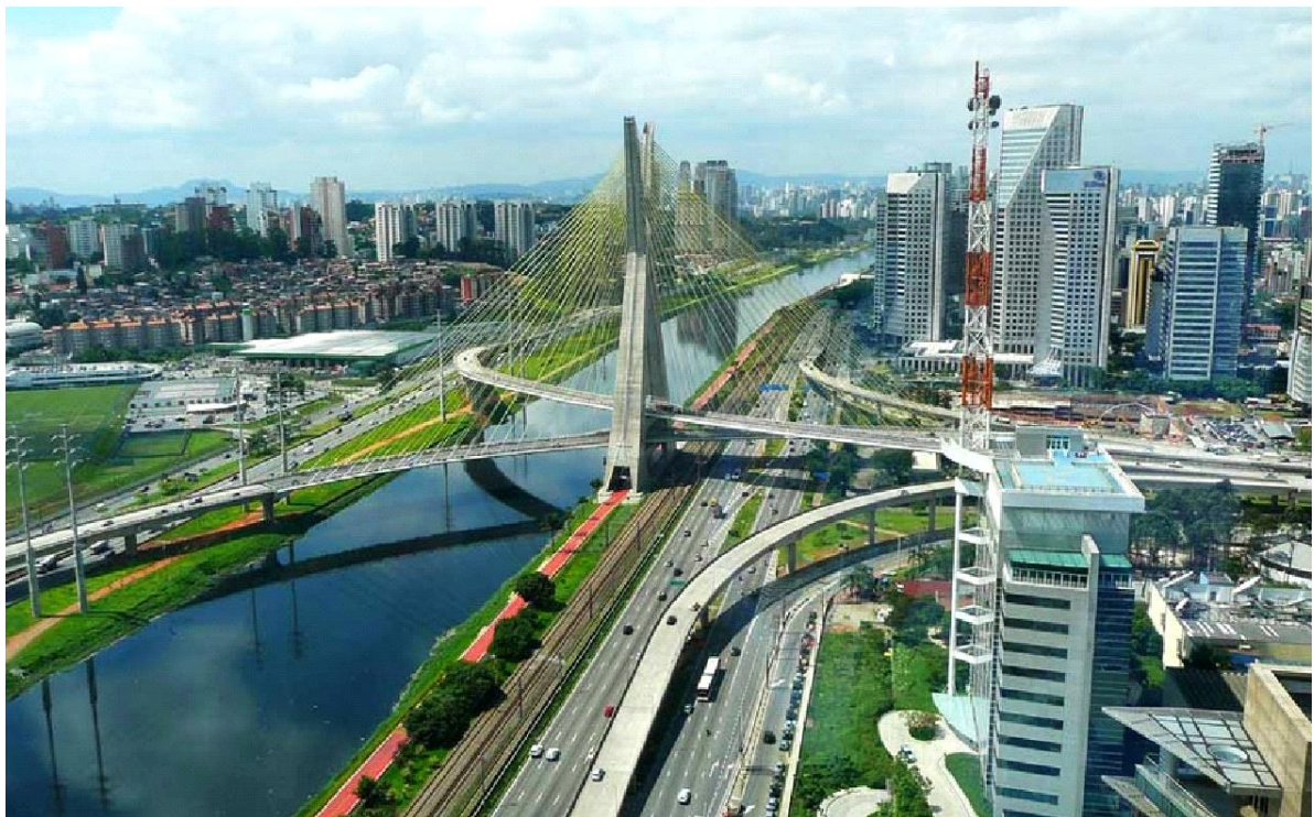
Figura 1 – Ponte Octávio Frias de Oliveira - Cidade de São Paulo - SP (COTRIM, 2013).
