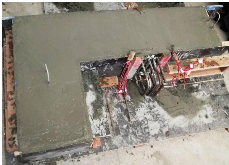
Figura 40 - Concretagem do pilar do modelo com consolo pós-concretado
