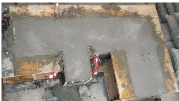
Figura 39 - Modelo Monolítico concretado
