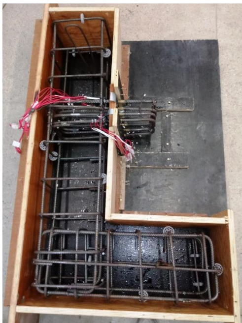
Figura 38 - Modelo com consolo pós-concretado preparado para concretagem
