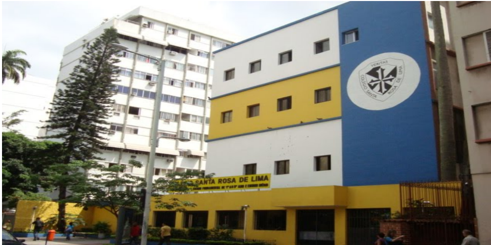
Figura 13: Fachada Colégio Santa Rosa de Lima
