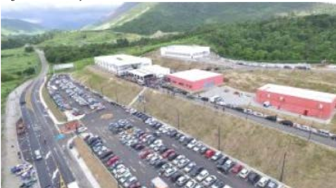
Figura 45 – Construção do IFF 24
