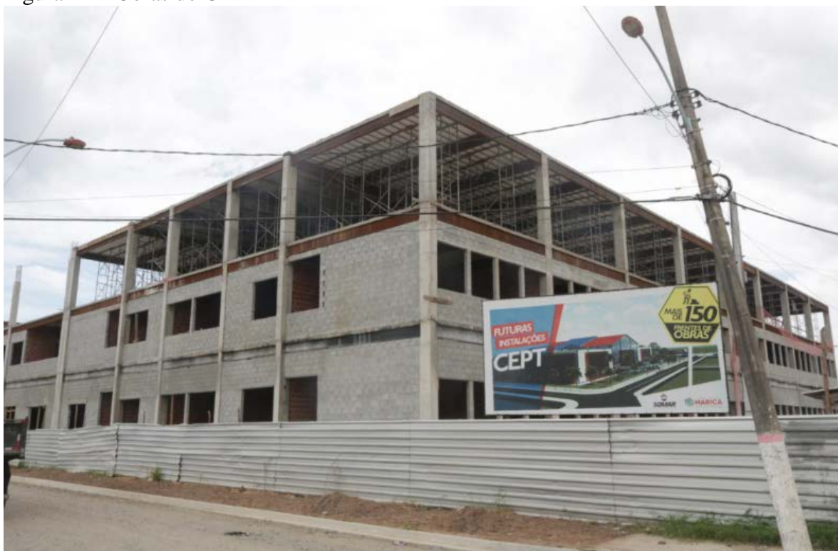
Figura 44 – Obras do CEPT 23
