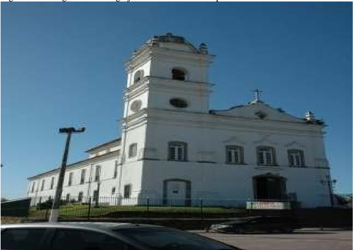
Figura 19 – Imagem atual da Igreja de Nossa Sr. a do Amparo
