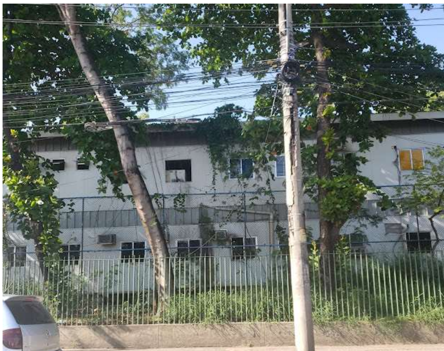
Figura 49 – Fachada frontal do Parque Ary Barroso; estrutura da PMERJ em uso
