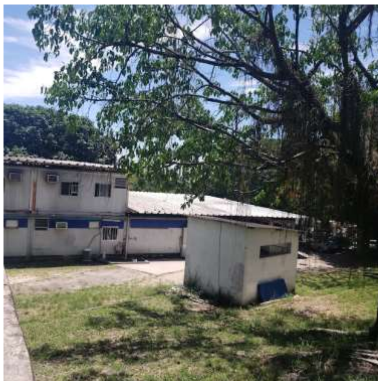
Figura 48 – UPA: vista interna do Parque
