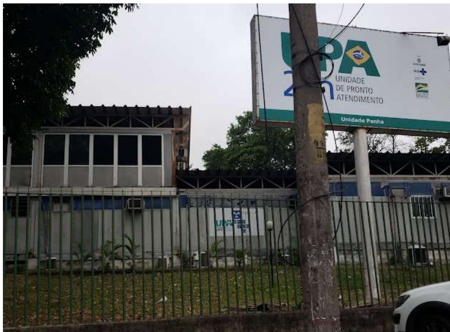
Figura 47 – Fachada frontal Parque Ary Barroso; UPA Penha
