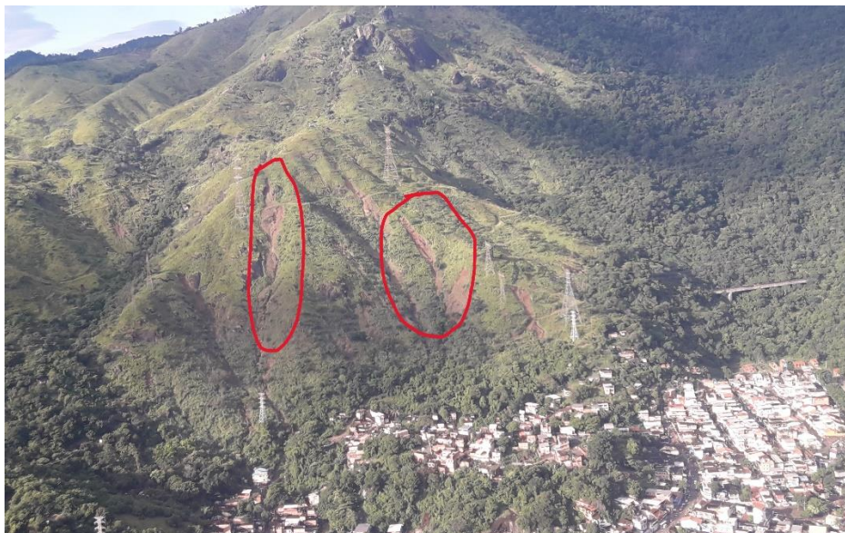
Figura 17- Pontos de escorregamento na vertente norte no bairro de Realengo
