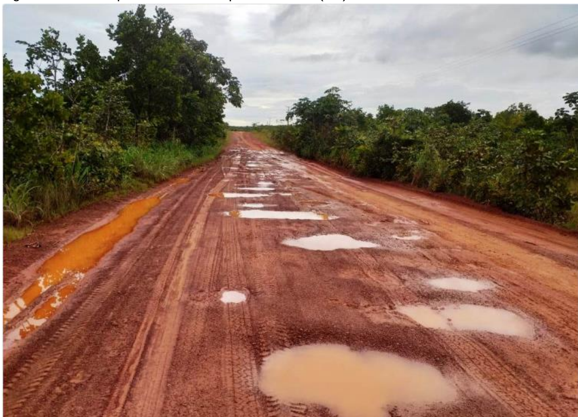
Figura 4 – TO-020 próximo ao município de Lizarda (TO) – 2020
