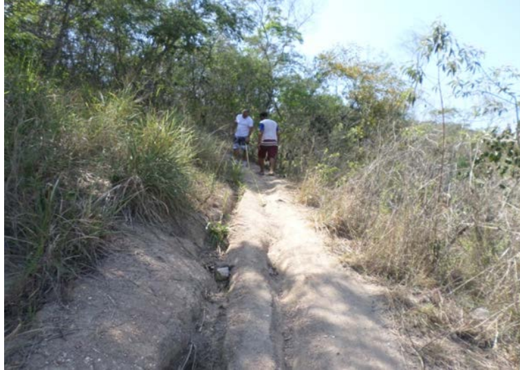
Figura 18 – Ponto 2. Deterioração da trilha
