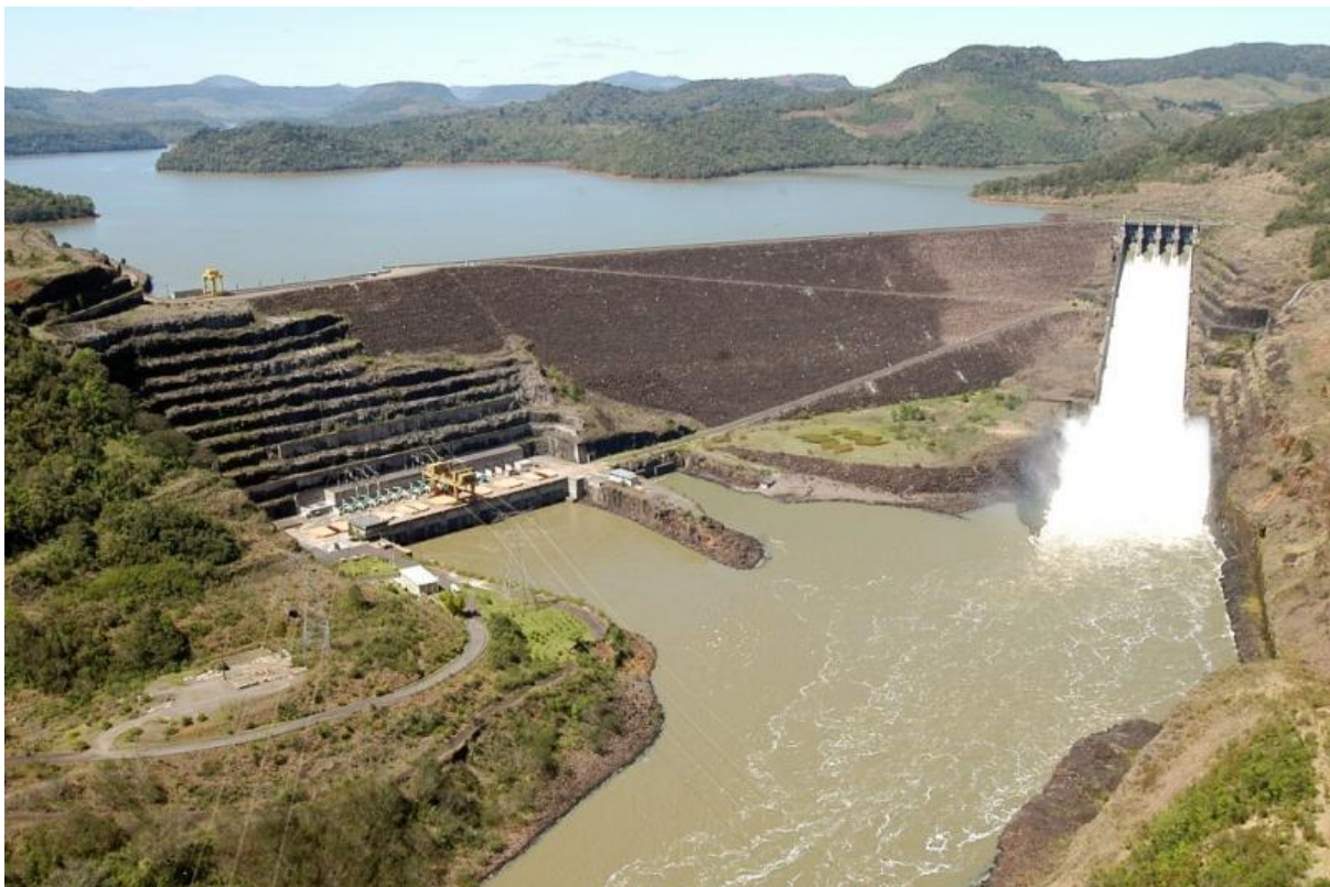
Figura 20 – Aspectos técnico-estruturais da UHE Foz do Areia no rio Iguaçu.
