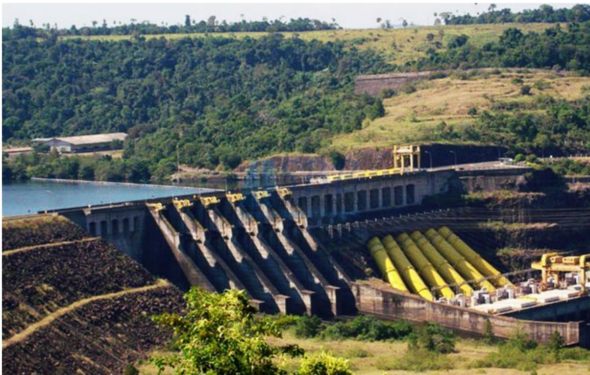
Figura 13 – Aspecto Infraestrutural da UHE Salto Osório, rio Iguaçu, no Paraná - Brasil.
