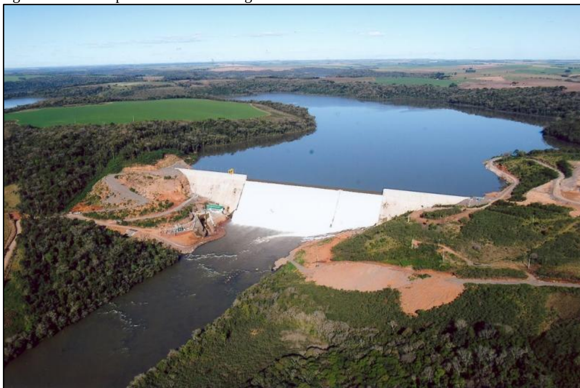
Figura 29 – Visão panorâmica da Barragem da UHE Santa Clara e entorno.
