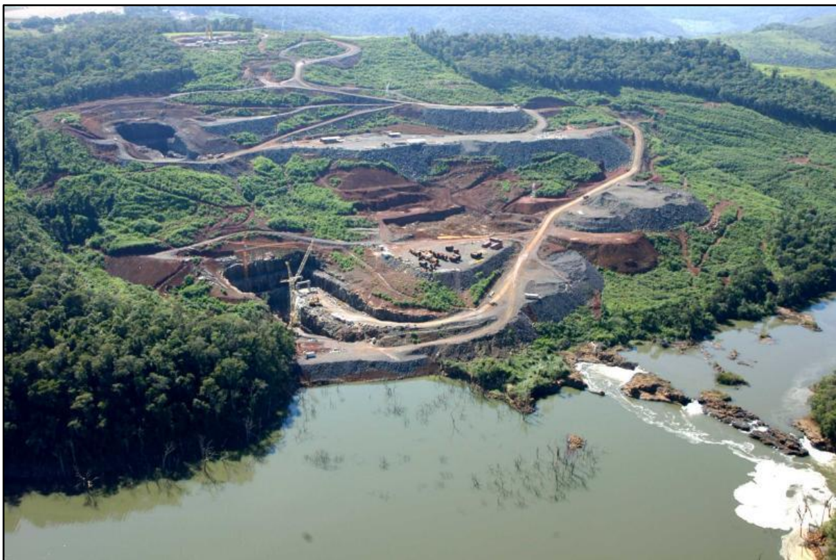
Figura 30 – Visão geral do Canteiro de obras da UHE Fundão.
