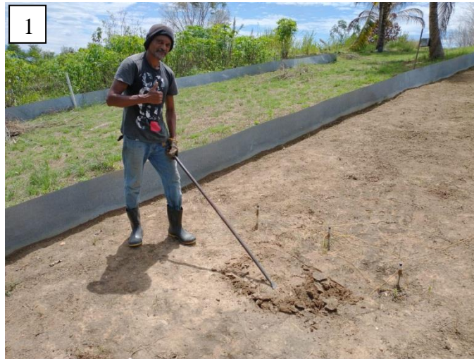
Figura 20 – Abertura das trincheiras nas parcelas
