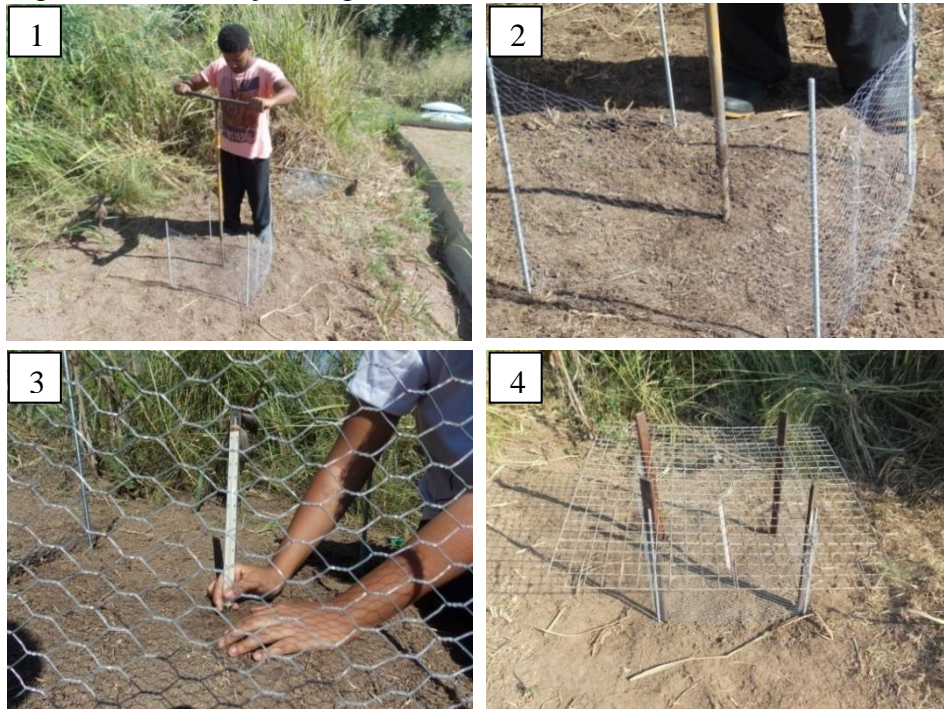
Figura 27 – Instalação do geotermômetro
