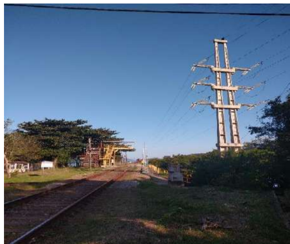
Figura 111 - Vista continental da estrada de ferro do TIG, localizado na Ilha Guaíba, em Mangaratiba
