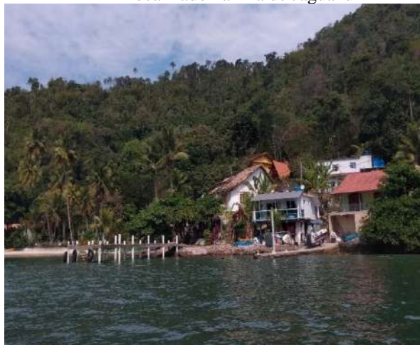
Figura 122 - Cais privativo na Praia da Estopa, localizado na Ilha de Jaguanum
