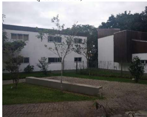
Figura 24 - Casa do gestor (à direita) e alojamentos (prédio ao fundo)
