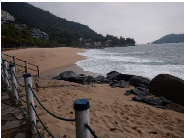
Figura 89 - Estrutura de concreto construída sobre a faixa de areia para acesso à piscina oceânica do Porto Real Resort
