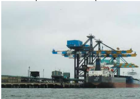
Figura 115 - Navio de grande porte atracado no terminal portuário da Baía de Sepetiba
