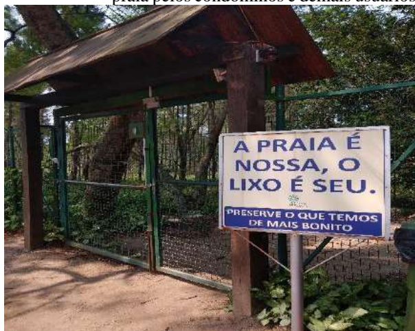
Figura 132 - Portão instalado dentro do Condomínio Aldeia dos Reis que controla o acesso à praia pelos condôminos e demais usuários
