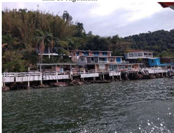
Figura 116 - Expansão de construções e descaracterização generalizada da Praia da Pitangueira (lado oeste), localizada na Ilha de Jaguanum
