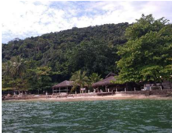
Figura 126 - Grande estrutura de restaurante (Restaurante Araçá de Jaguanum), localizado na Praia do Araçá, Ilha de Jaguanum, com construção sobre muro de pedra descaracterizando a faixa natural da areia
