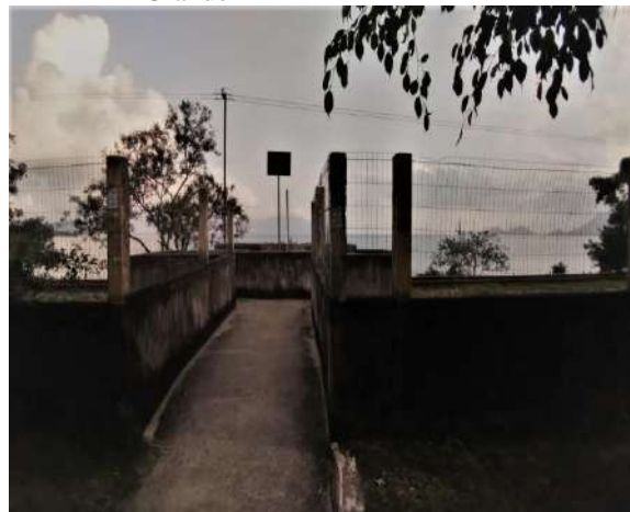
Figura 36 - Infraestrutura criada sobre a linha férrea para travessia de pedestre e acesso à Praia Grande
