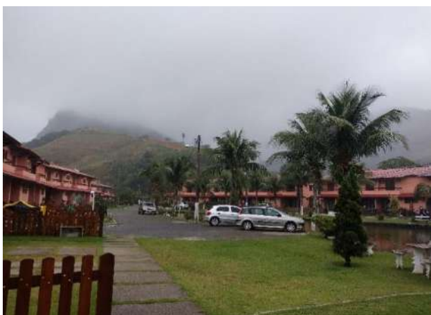
Figura 55 - Condomínio Pontal de Muriqui
