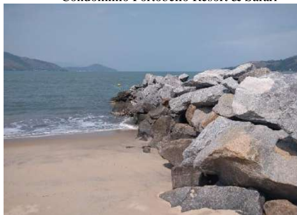
Figura 72 - Enrocamento demarcando limite leste de privatização de praia defrontante ao Condomínio Portobello Resort & Safari
