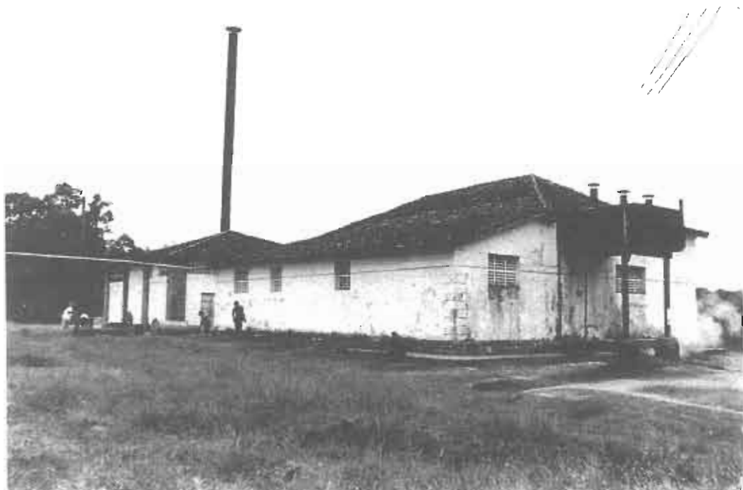
Fig. 7: Prédio onde funcionava a lavanderia. Fonte: Arquivo IMASJM, 1976
