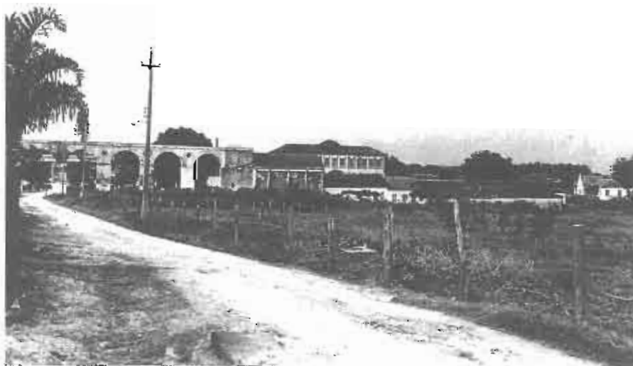
Fig. 4: Vista do aqueduto, Pavilhão 1 e oficinas. Fonte: Arquivo IMASJM, 1976
