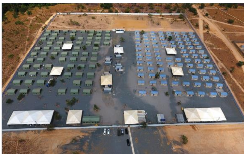
Figura 15 - Vista aérea do abrigo Rondon 3 - Boa Vista
