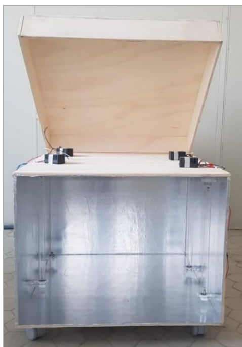
Figura 7 – Visão frontal da CHC em construção.
