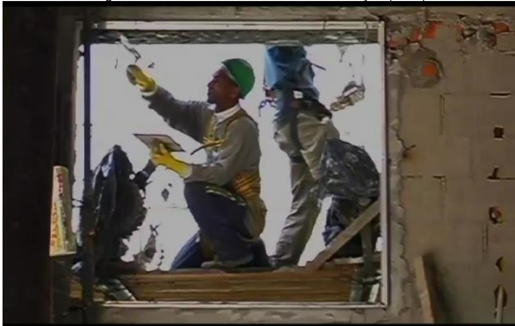
Figura 18 - Homens trabalhando em Construção (2006)
