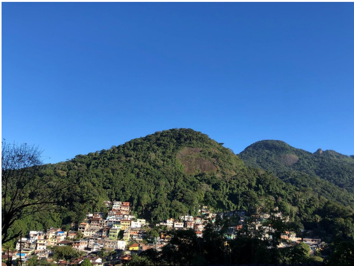
Foto 2 - Tijuáçu: casas construídas em área de encosta
