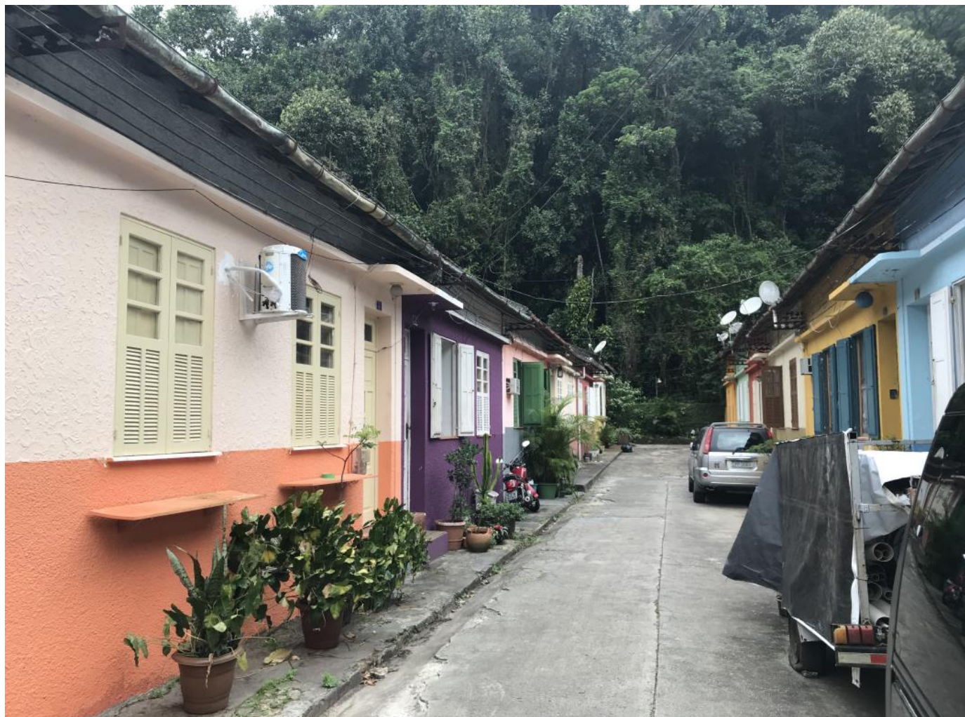
Foto 7 - Rua Boa Vista: antiga vila operária da fábrica de tecidos Lanifícios Boa Vista.
