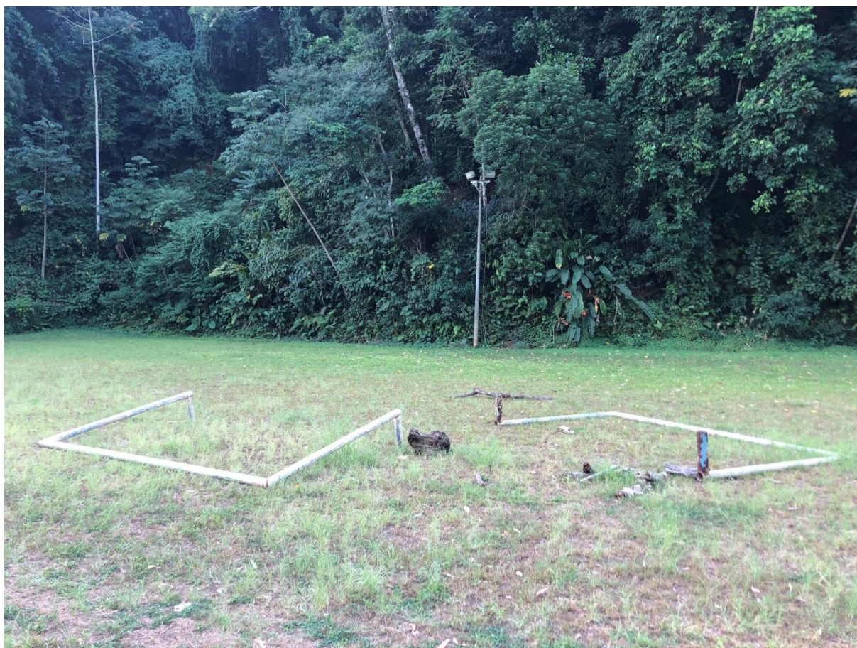
Foto 14 - Campo do Agrícola: abandono com traves e alambrados caídos.
