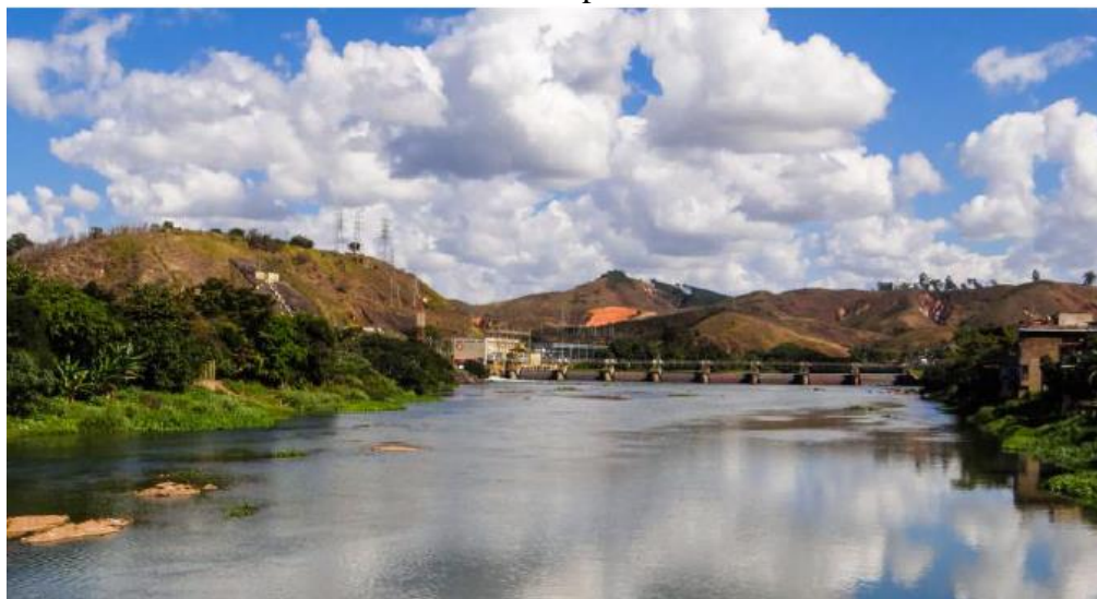
Figura 09 – Barragem de Santa Cecília onde ocorre a transposição de parte da água do Rio Paraíba do Sul para o Rio Guandu
