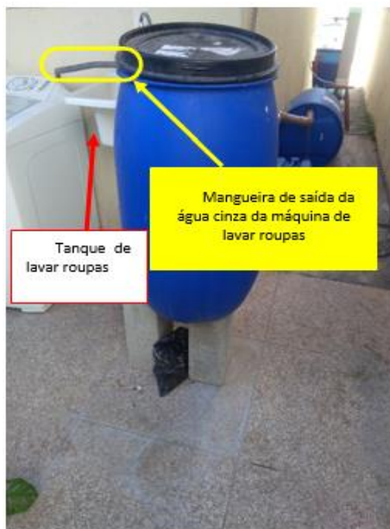
Figura 45 – Ponto de captação e descarte da água cinza oriunda da máquina de lavar roupas
