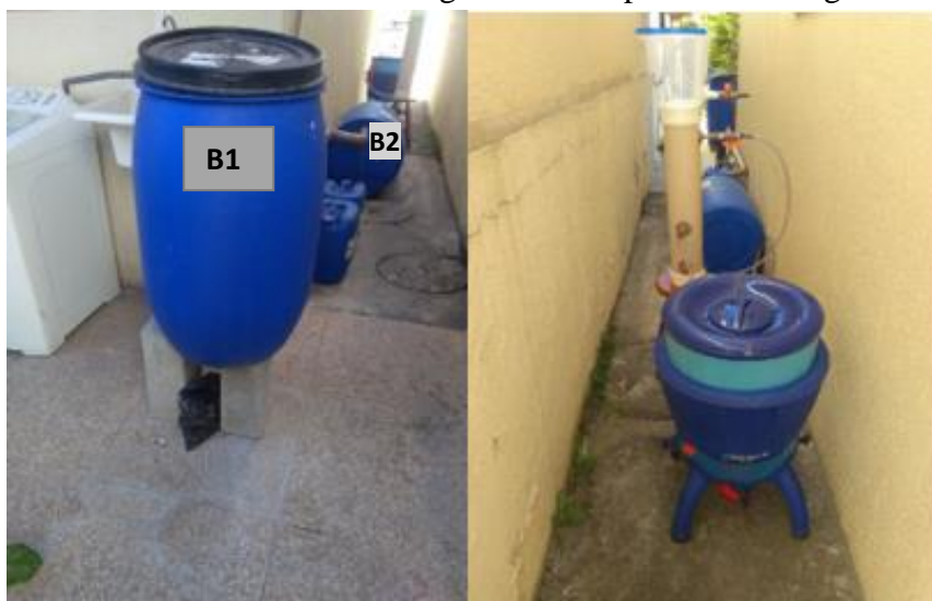
Figura 44 – Configuração e posicionamento das unidades do projeto experimental do sistema de tratamento das águas cinzas após sua montagem
