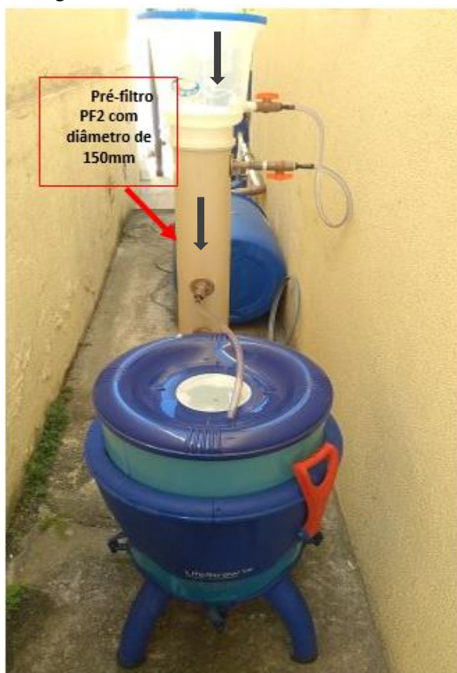
Figura 41 –Pré-filtro com diâmetro de 150mm
