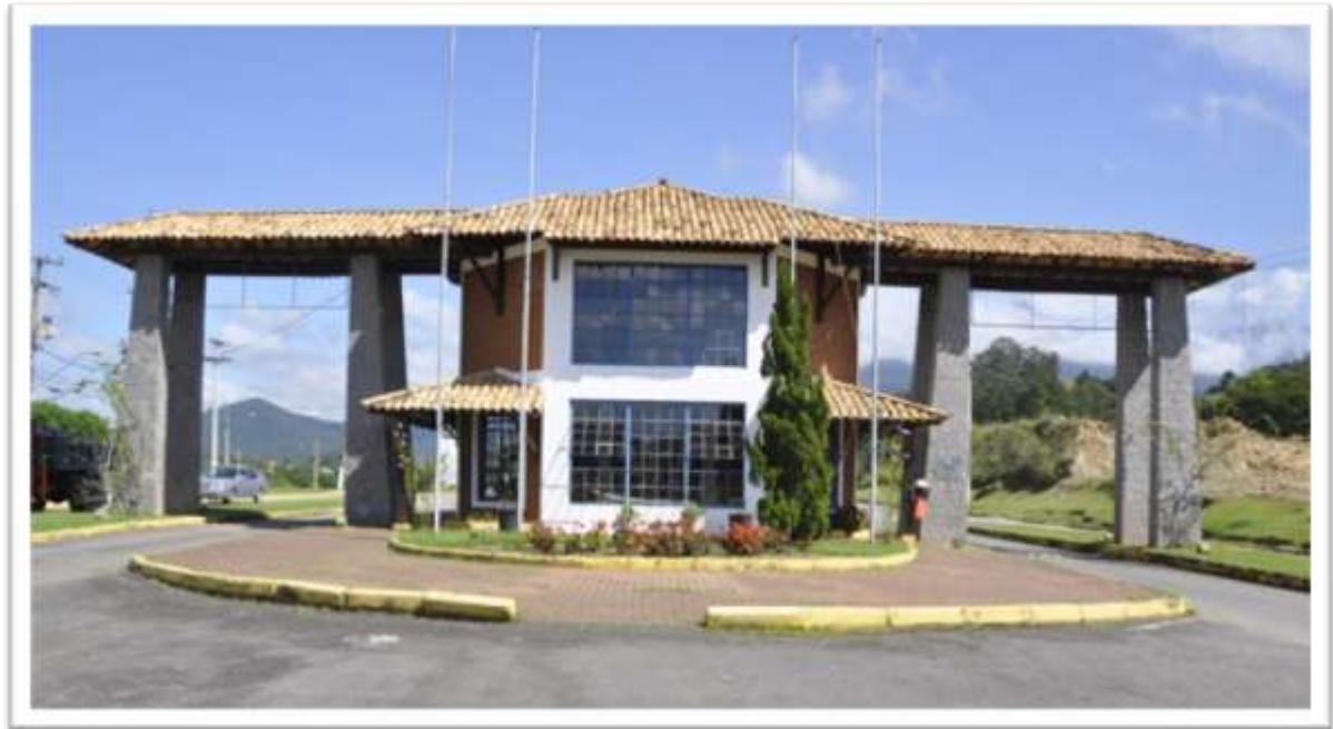
Figura 3 - Portal da Entrada de Penedo-Itatiaia/RJ
