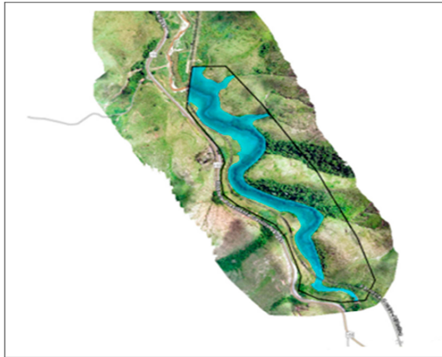
Figura 21 – Ortofoto considerando o limite de uma ponte ferroviária desativada em uma rodovia estadual.
