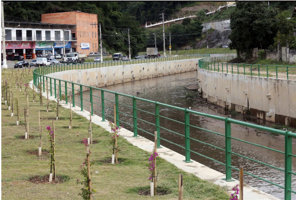
Figura 7 – Trecho da canalização do Rio Bengalas, calçamento e plantio de mudas no Jardim Ouro Preto, Distrito de Conselheiro Paulino, Nova Friburgo, RJ.
