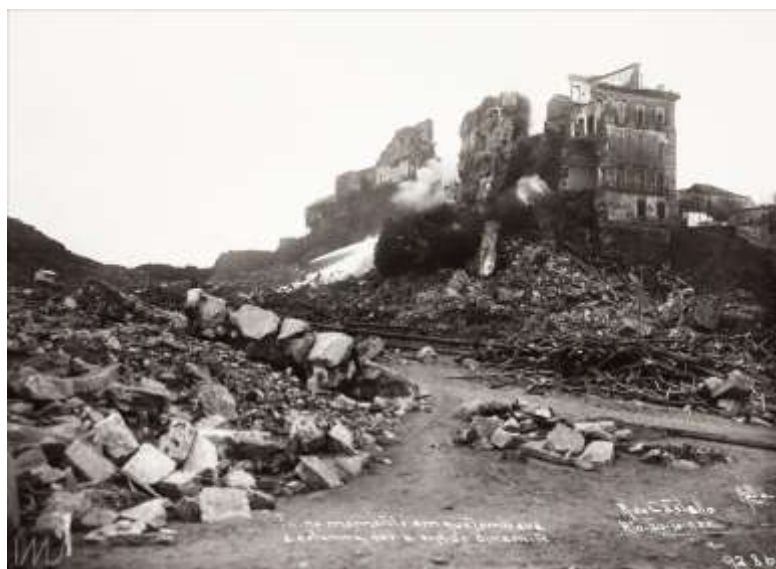
Figura 15 - Processo de demolição do Morro do Castelo
