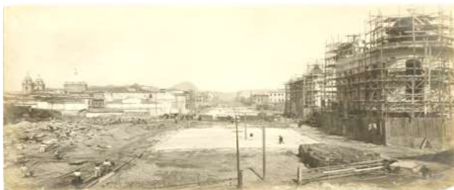
Figura 13 - Avenida Central: vista panorâmica durante pavimentação.
