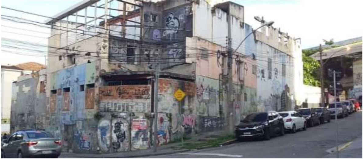
Figura 26 - Grafites e pichações variadas em construção abandonada Rua Hermengarda
