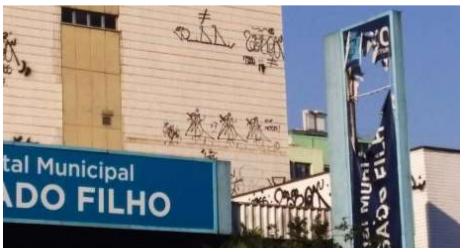
Figura 20 - Pichação no Hospital Municipal Salgado Filho (Rua Arquias Cordeiro)
