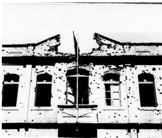
Figura 60 - Detalhe da fachada do quartel da Polícia Militar do RN
