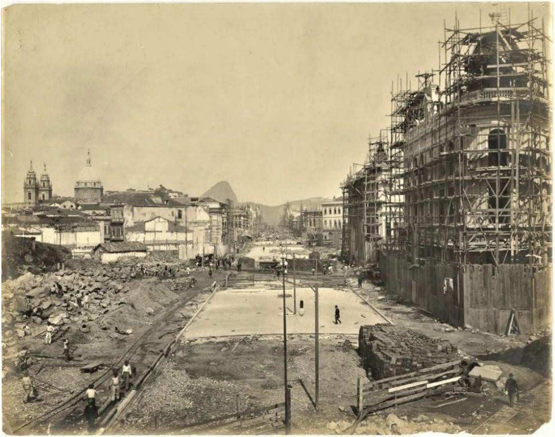
Figura 42. “Avenida Central: vista panorâmica durante os trabalhos de pavimentação”.
