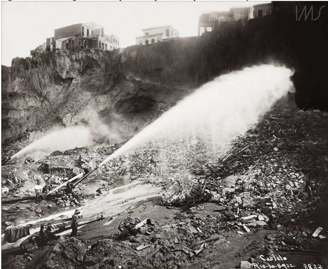
Figura 63. Jatos de água foram responsáveis pela maior parte de demolição do Morro do Castelo
