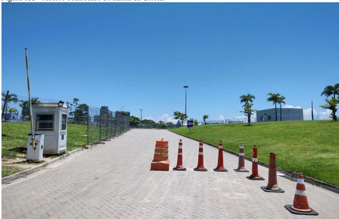
Figura 133 - Acesso controlado à Marina da Glória.
