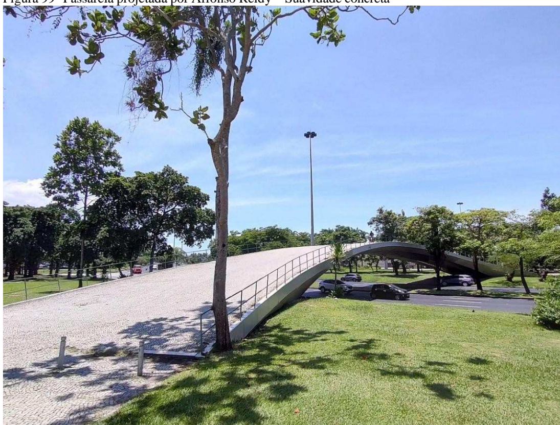
Figura 99- Passarela projetada por Affonso Reidy - Suavidade concreta
