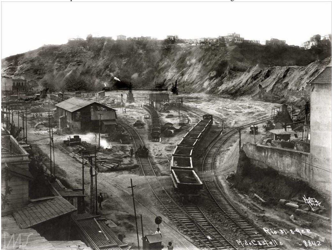
Figura 65. À medida que o morro era demolido seus escombros eram prontamente transportados até a Baía de Guanabara por um sistema ferroviário de 6 locomotivas e 50 vagões
