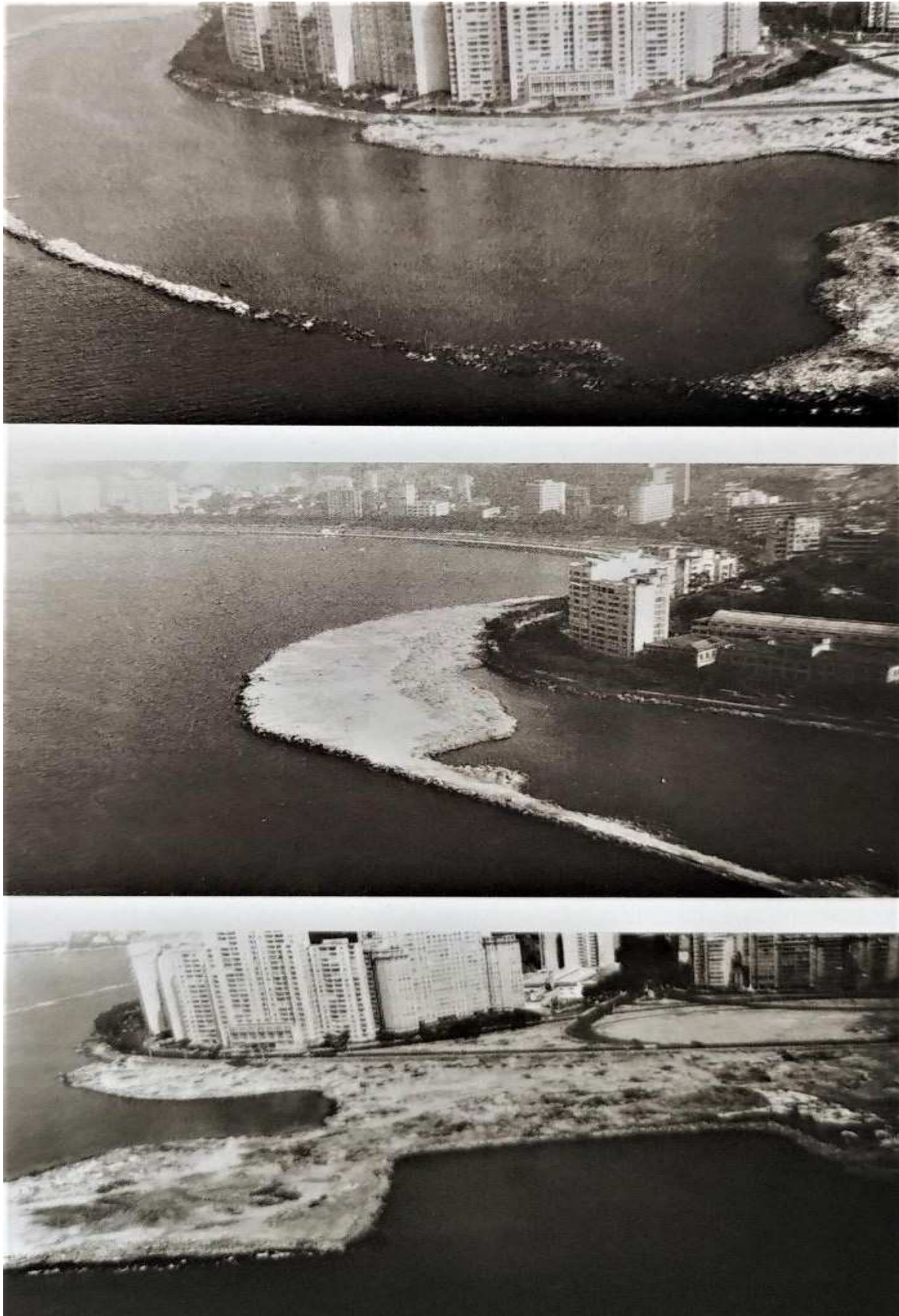
Figura 80 - Nessa sequência fotográfica é possível acompanhar a técnica da barragem de enrocamento sendo utilizada no aterramento da Baía de Guanabara – na altura do Morro da Viúva
