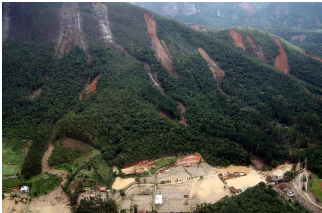
Figura 2 - Consequências do Desastre de 2011 em Petrópolis/RJ.
