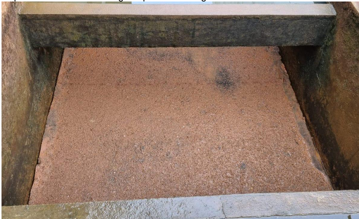
Figura 4 - Partículas retidas no fundo do filtro da ETA após o procedimento de limpeza do sistema de filtragem que utiliza coagulante à base de ferro.
