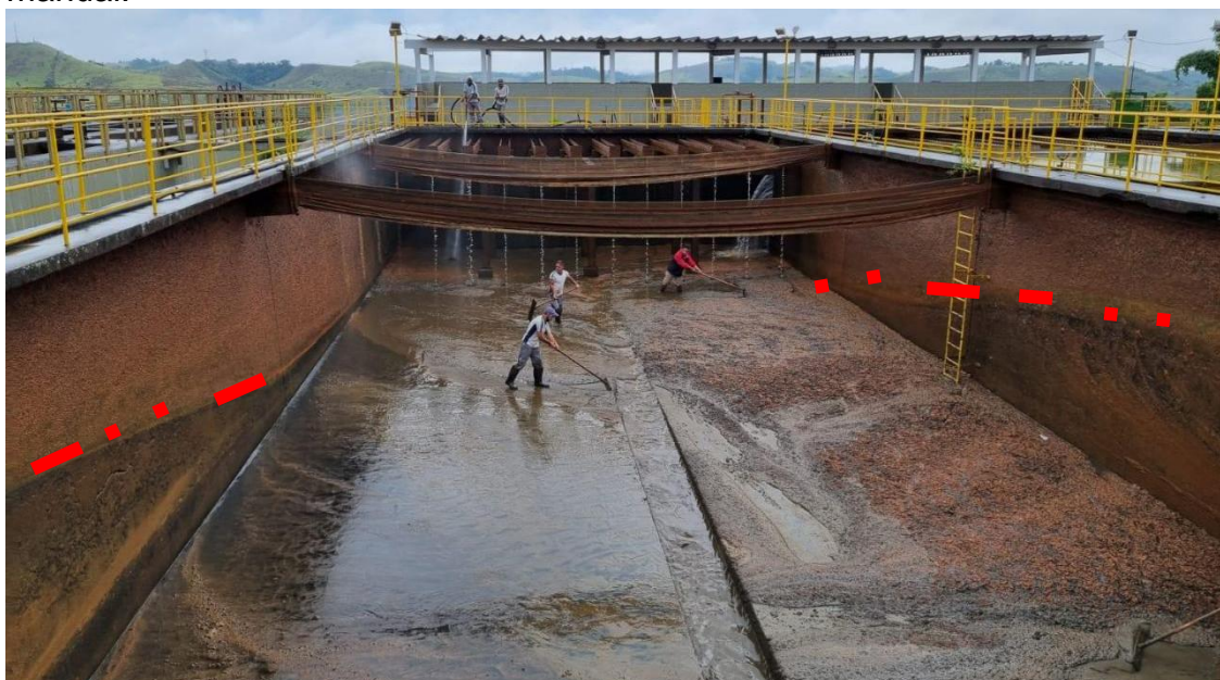
Figura 7 - Perfil de lodo observado ao longo do decantador durante a limpeza manual.
