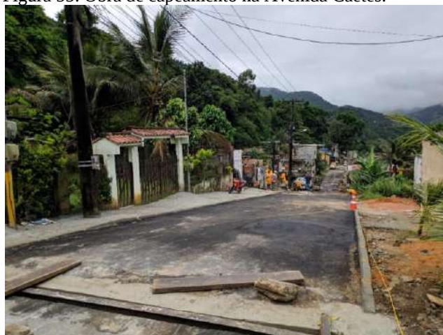
Figura 55. Obra de capeamento na Avenida Caetés.
