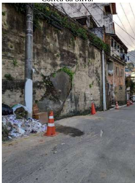
Figura 49. Bloco presente na rua Lincoln Corrêa da Silva.
