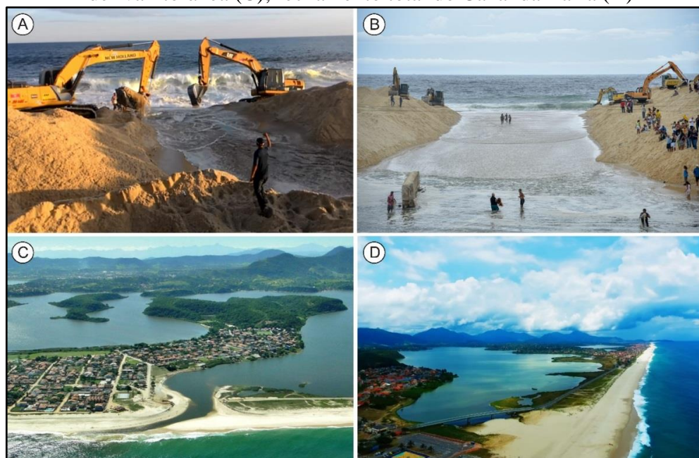
Figura 3 - Abertura artificial do Canal da Barra para rebaixar o nível das lagoas após a ocorrência de chuvas torrenciais (A e B). Fechamento parcial do Canal da Barra devido a remobilização de sedimentos transportados pela corrente de deriva litorânea (C); fechamento total do Canal da Barra (D)
