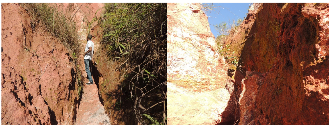
Figura 34 - Acúmulo de sedimentos na parte a jusante da voçoroca
