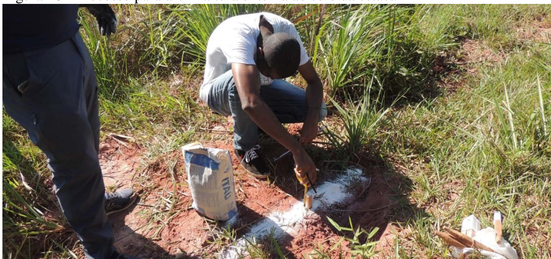
Figura 18 - Processo para aferir altura externa ao solo da estaca
