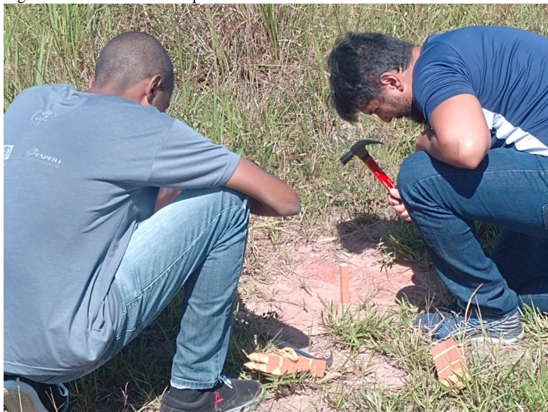
Figura 13 - Processo de estaqueamento
