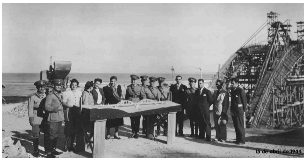
Figura 44 - Maquete da ponte da Marambaia no lançamento da obra
