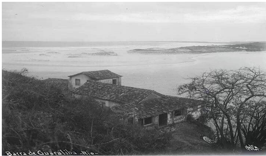
Figura 50 - Casa do Porto. Propriedade do Comendador Breves - restinga da Marambaia
