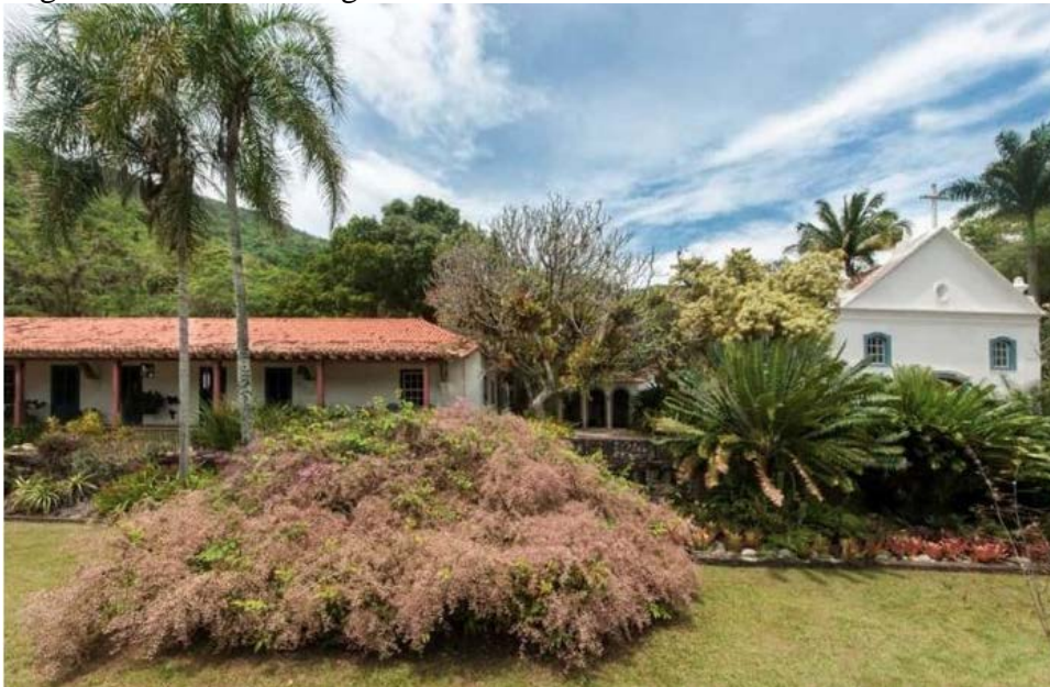
Figura 33- Vista da chegada ao museu
