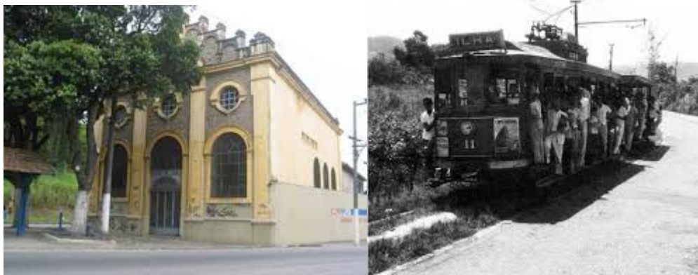
Figura 69 - Antiga estação - hoje sede da Comlurb. Bonde da Ilha
