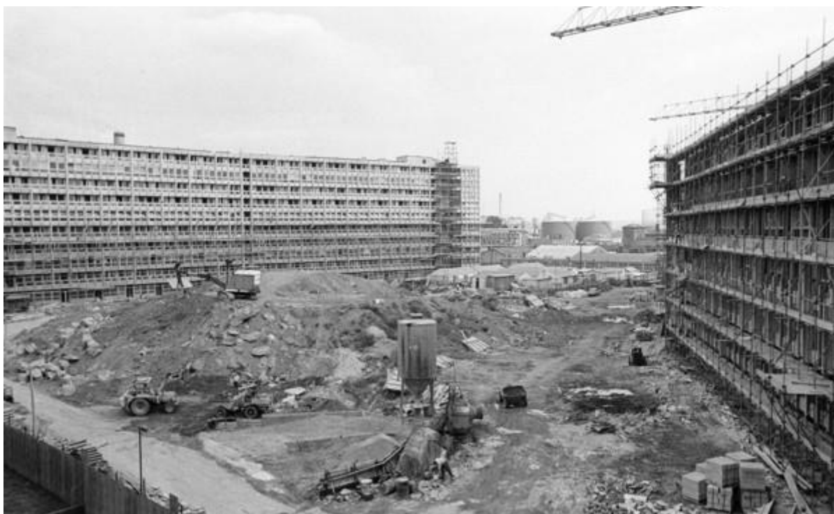
Figura 103 - Construção da colina do Robin Hood Gardens, 1972
