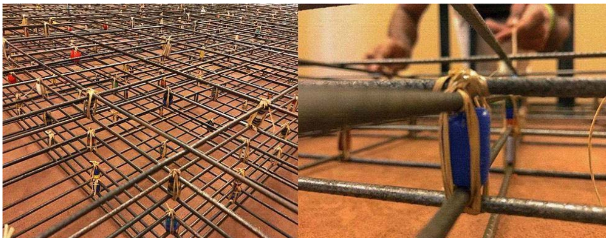
Figura 53 - Fundação. Gilson Plano, 2020
