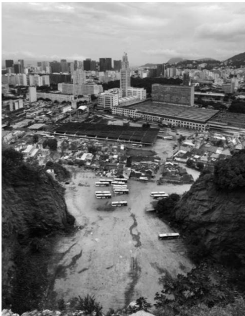
Figura 116 - Vazio da Pedreira da Central do Brasil
