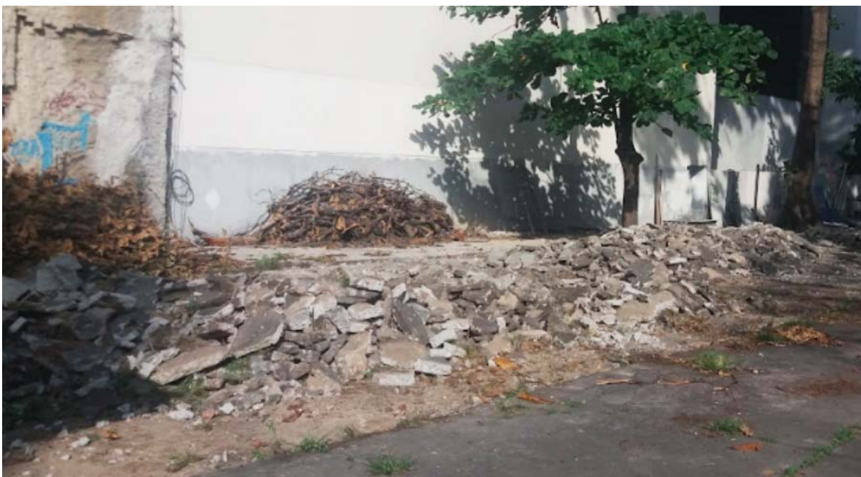
Figura 74 - Pilha de concreto retirado na ESDI
