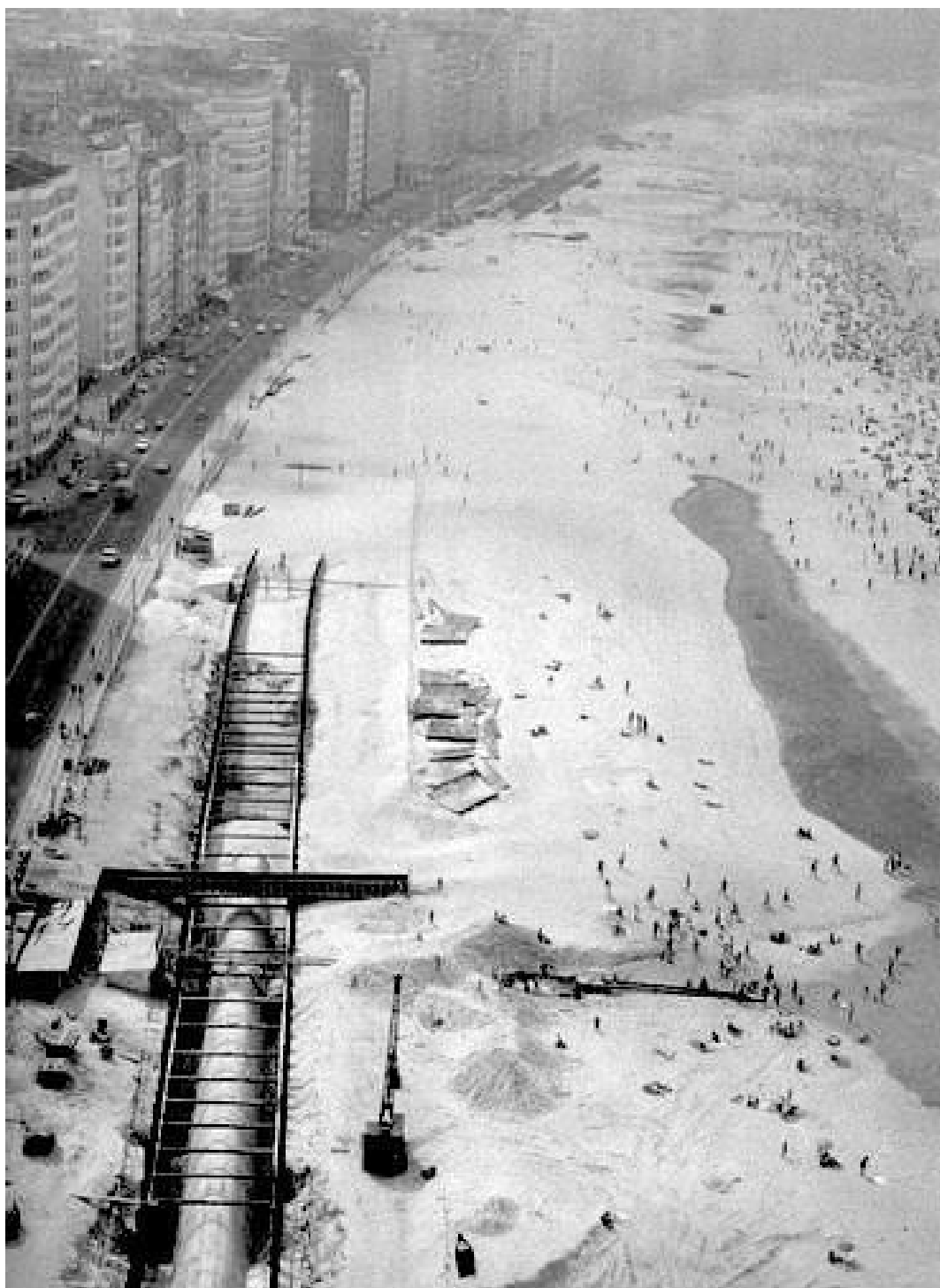
Figura 81 - Obras de drenagem e alargamento da Praia de Copacabana
