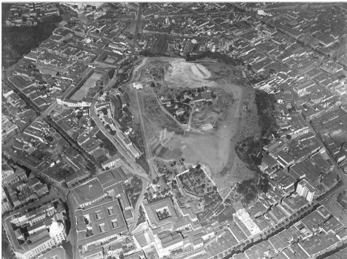
Figura 101 - Morro de Santo Antônio antes de sua demolição
