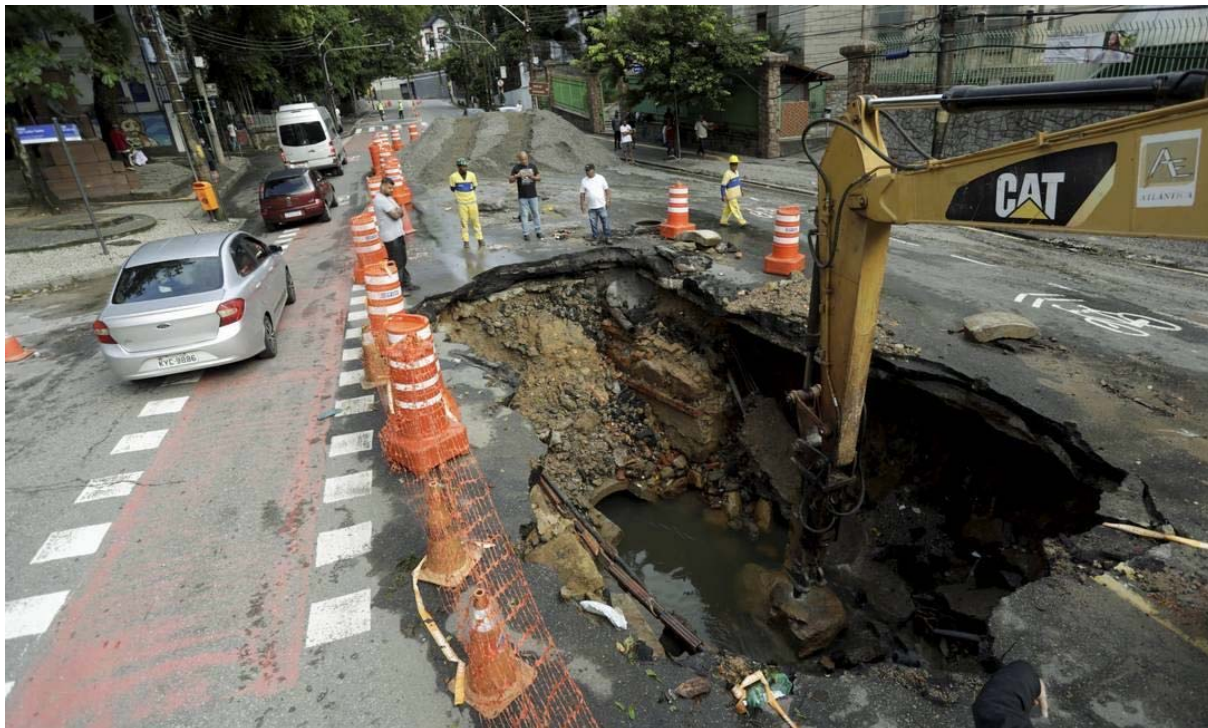
Figura 108 - Dragagem do Rio Carioca após rompimento de galeria, 2022
