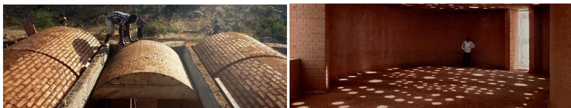
Figura 8- Construção de Abóbadas, biblioteca de Gando.
