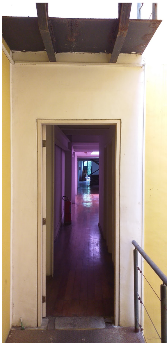
Figura 20 . Sobre passarela metálica, entre-casas.
