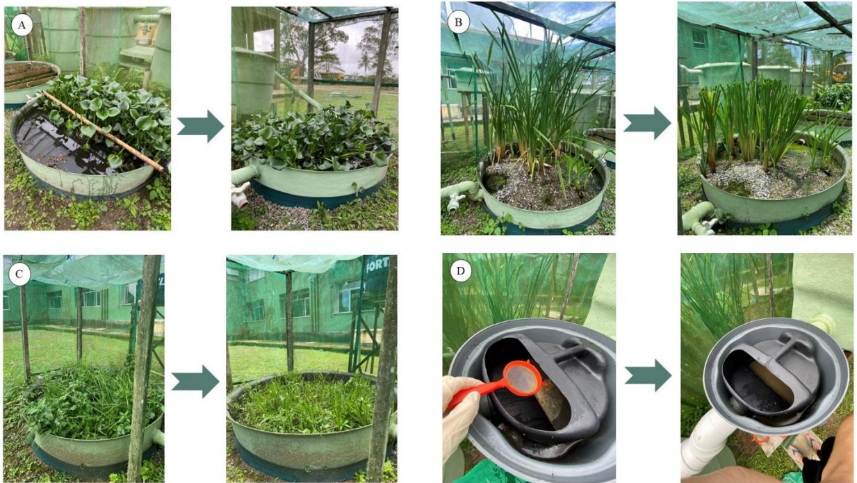
Figura 22 – Manutenção Geral do EE: (A) Retirada de metade do Aguapé do WC1; (B) Poda da Taboa do WC2; (C) Poda das gramíneas do WC3 e (D) Manutenção da caixa de gordura.
