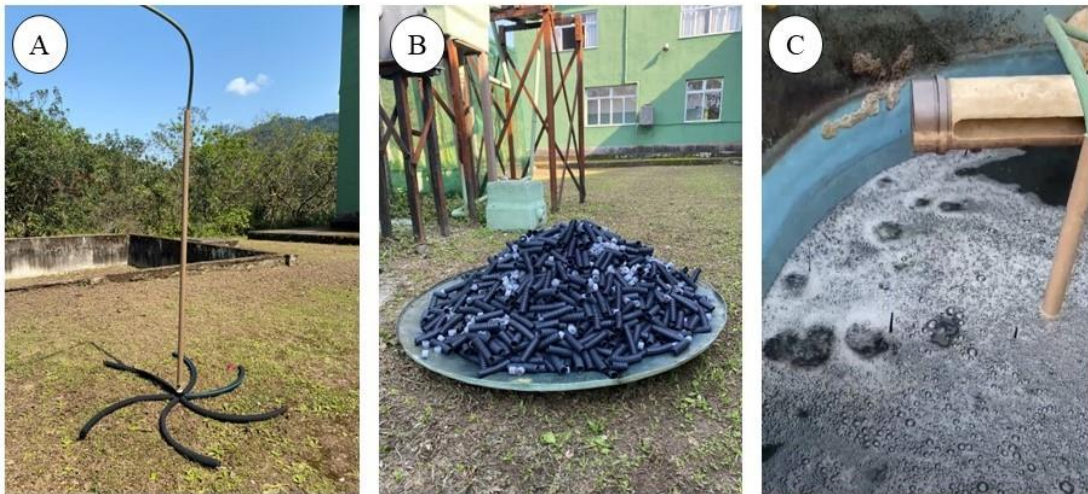
Figura 27 - Reparos feitos no Filtro Aerado Submerso. (A) Estrutura de Mangueiras porosas; (B) Mídias plásticas; (C) Tanque em pleno funcionamento.
