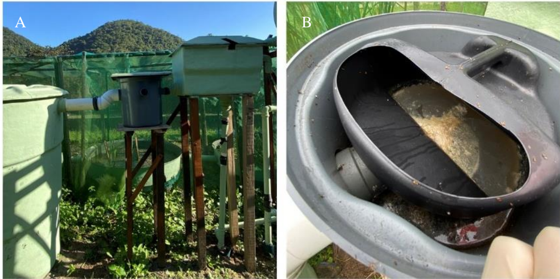
Figura 9 - Caixa de Gordura do EE: (A) Vista externa e (B) vista por dentro com detalhe da gordura.
