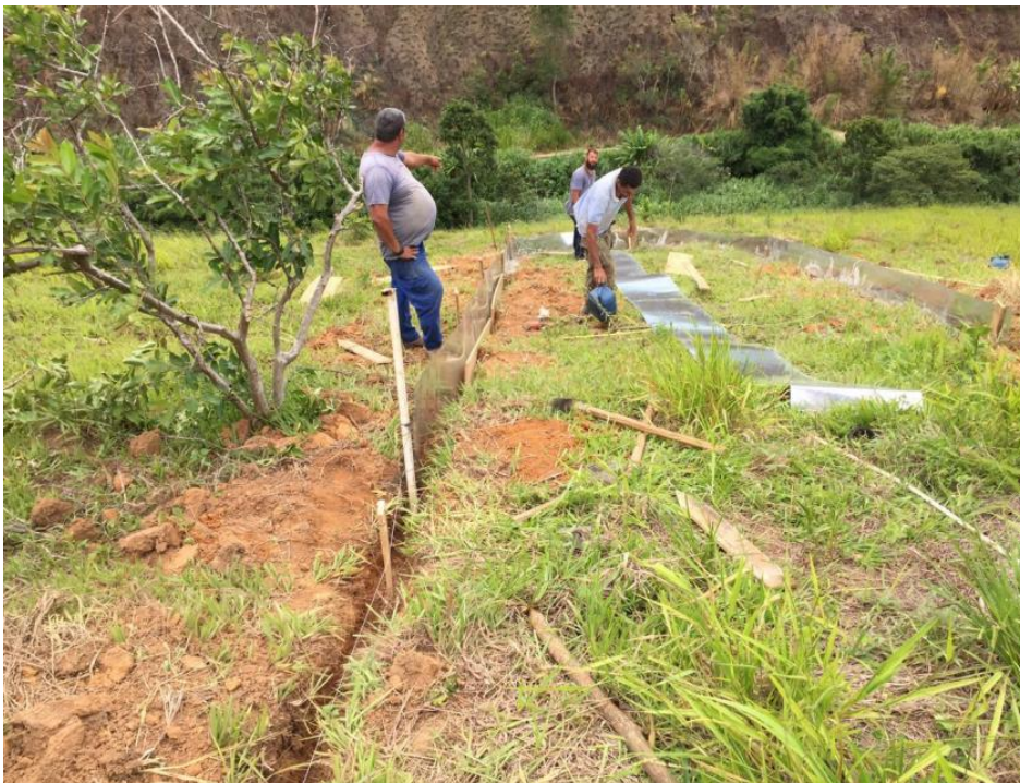
Figura 24 – Abertura de valetas para fixação das chapas de zinco ao solo.
