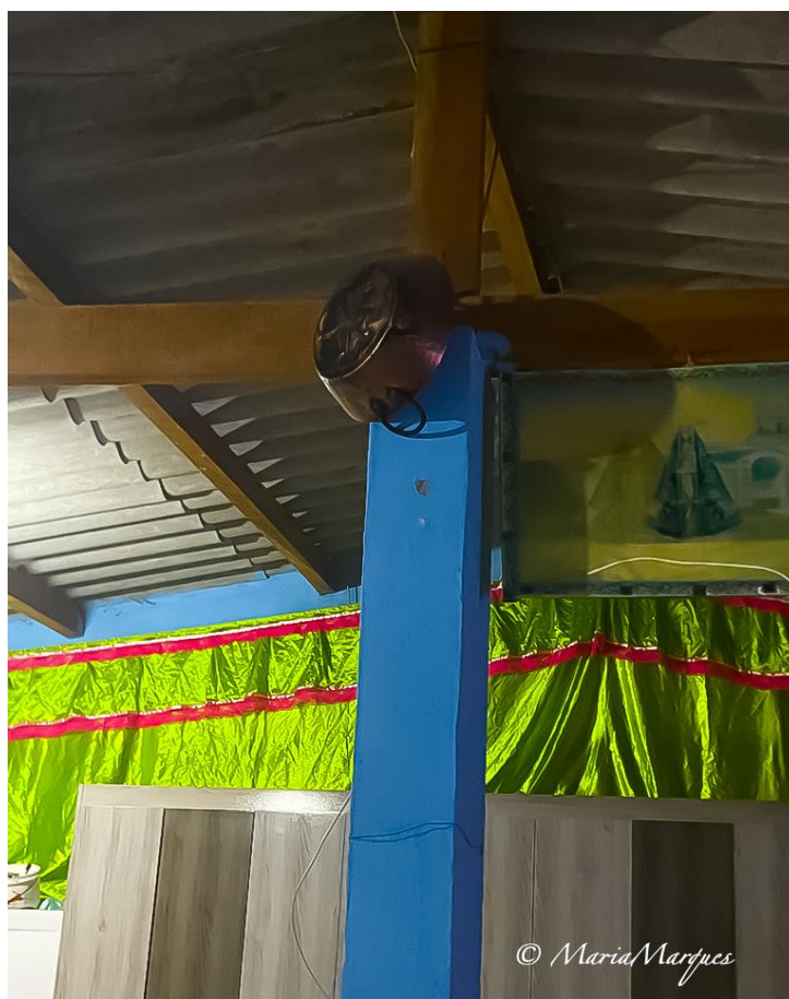
Figura 118 - Cumeeira da casa de Paloma
