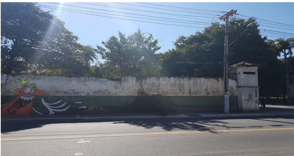
Fotografia 2 – Fachada em frente aos setores 1, 2 e 3
