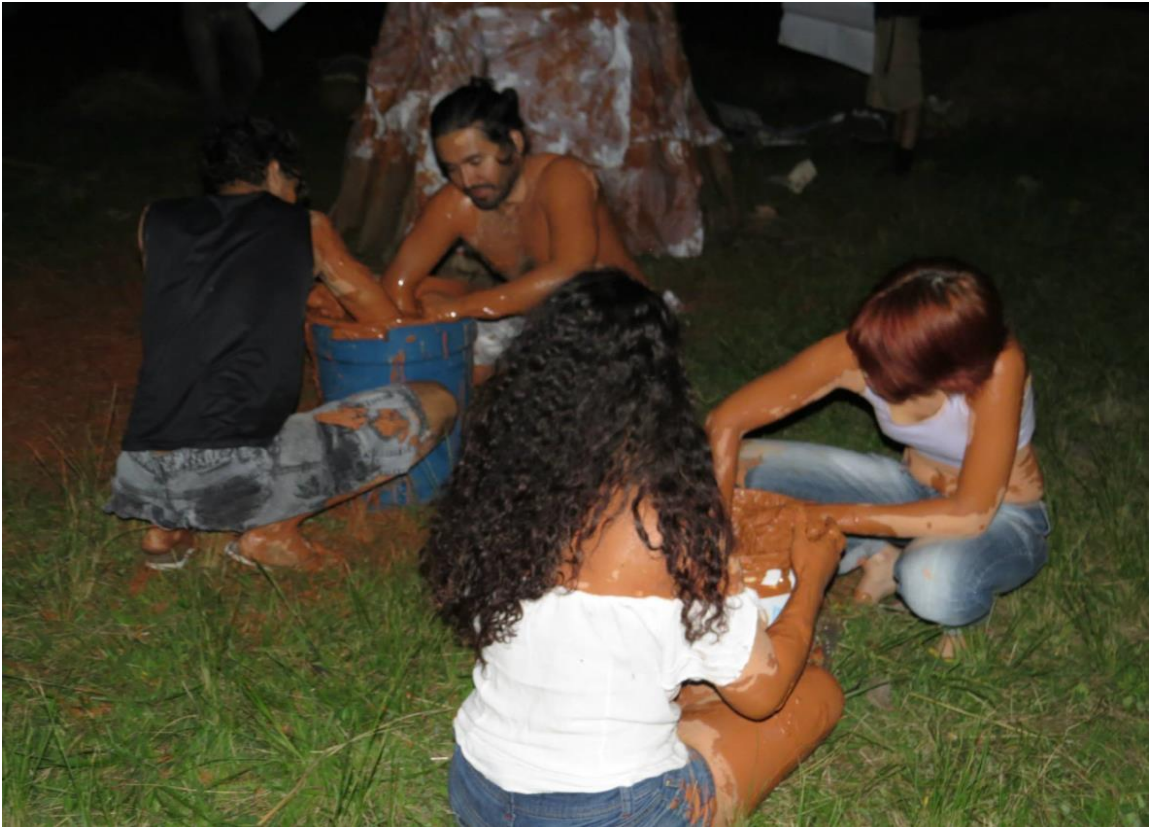
Cobertura do forno de papel. Preparo da barbotina. Fonte: CoAr, 2014.
