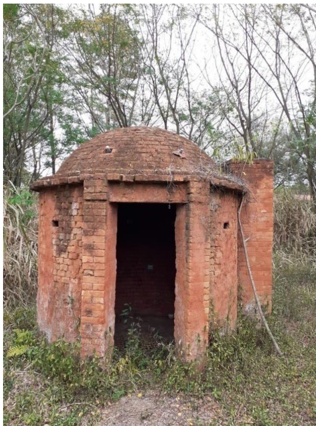
Figura 30 - Forno atualmente sem utilização.
