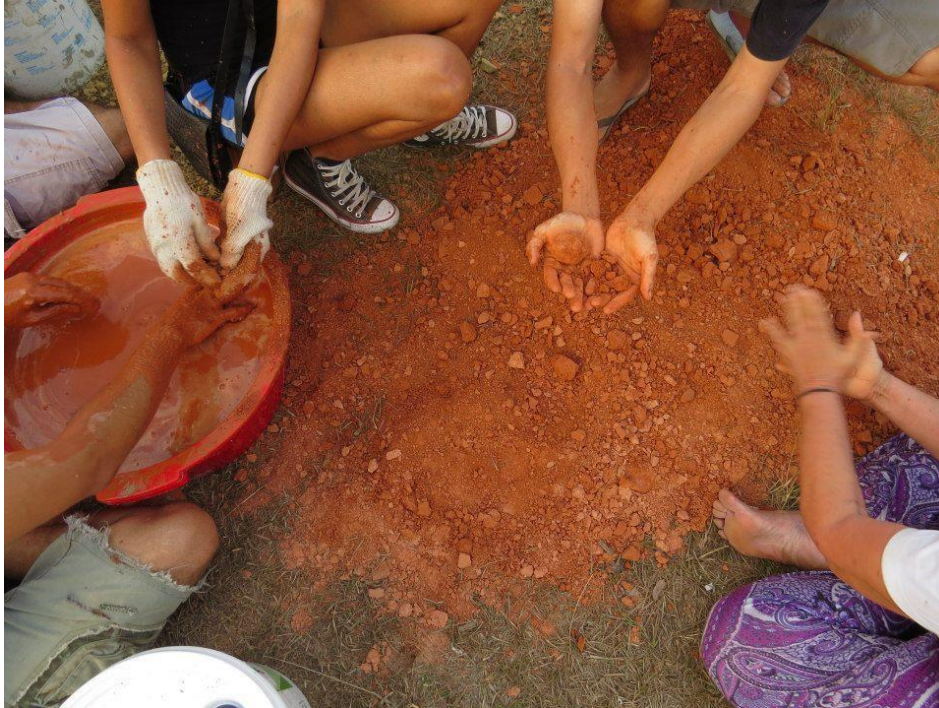
Figura 19 – Mistura das argilas para a montagem do forno.
