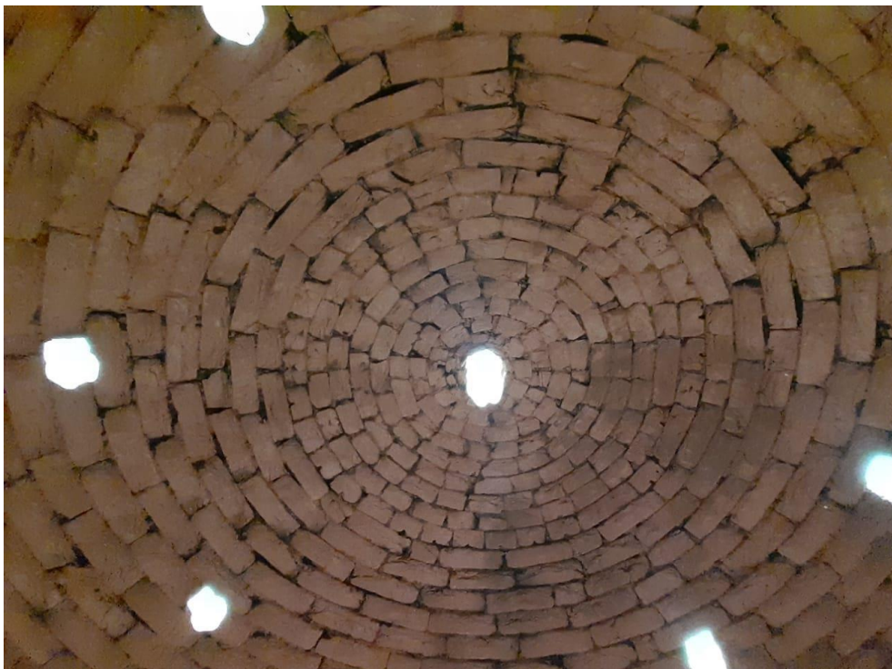
Figura 29 - Abóboda no interior do forno.
