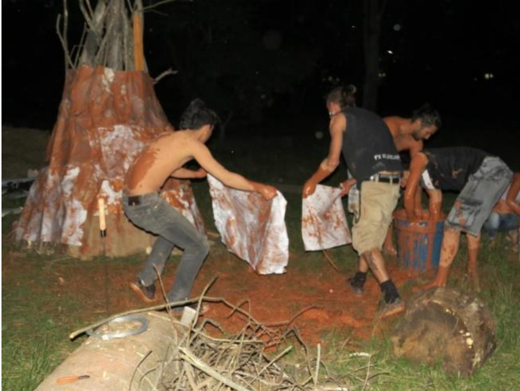
Cobertura do forno de papel. Colagem do papel com barbotina. Fonte: CoAr, 2014.
