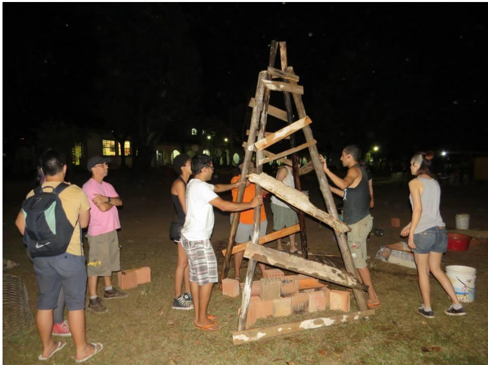
Figura 20 - Estrutura interna de madeira para forno de papel.
