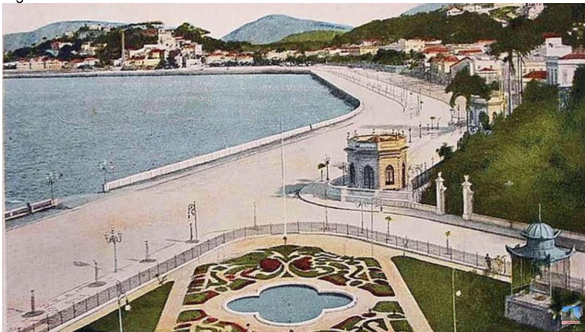
Figura 15 - Avenida Beira Mar na altura da Praia de Santa Luzia
