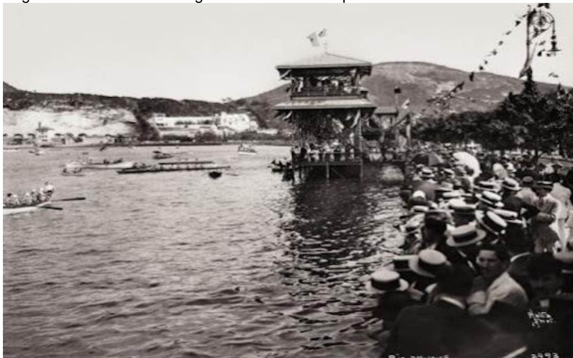
Figura 25 - Pavilhão de Regatas visto de lado a partir da mureta da Av. Beira-mar
