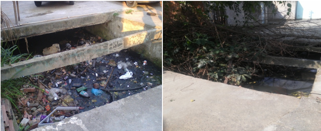
Figuras 37 e 38 - Galeria de esgotos - anos 2016 e 2021.
