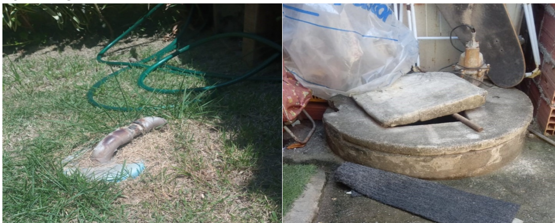
Figuras 52 e 53 - Poço artesiano domiciliar e poço raso domiciliar – bairro Jardim Catarina
