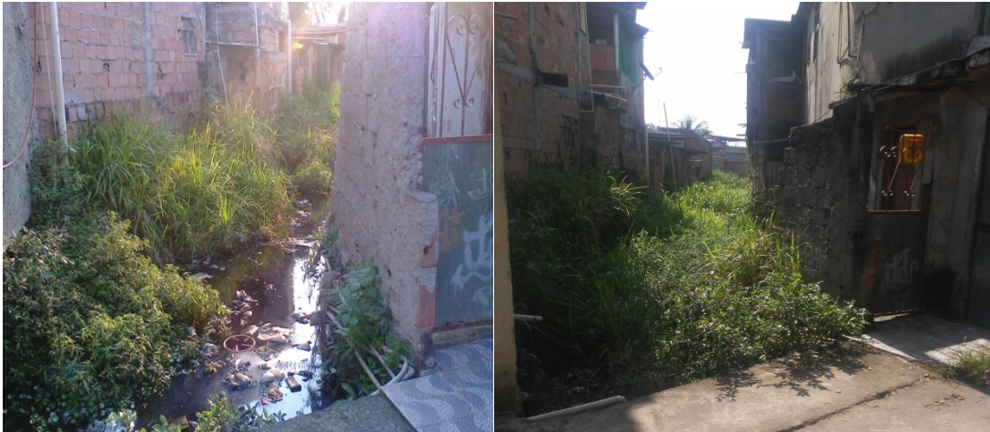
Figuras 35 e 36 - Rio receptor de esgotamento sanitário - anos 2016 e 2021
