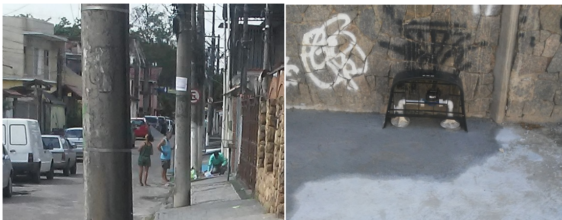
Figuras 31 e 32 - Instalação de hidrômetros nas residências do setor
