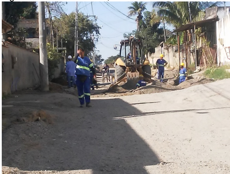
Figura 45 - Implantação de rede de abastecimento de água - bairro Bom Retiro, ano de 2019
