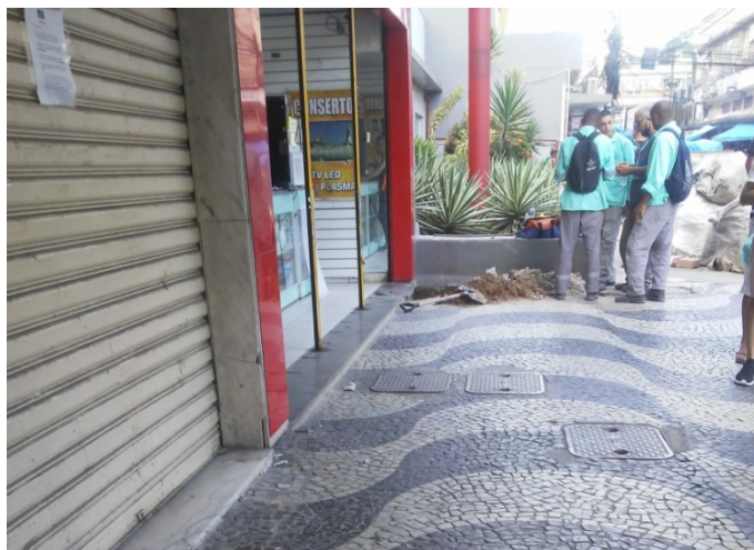
Figura 57 - Instalação de hidrômetro em loja do centro comercial do Alcântara
