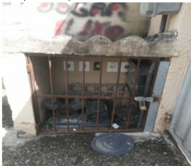
Figura 48 - Bomba de sucção residencial compartilhada por cinco residências
