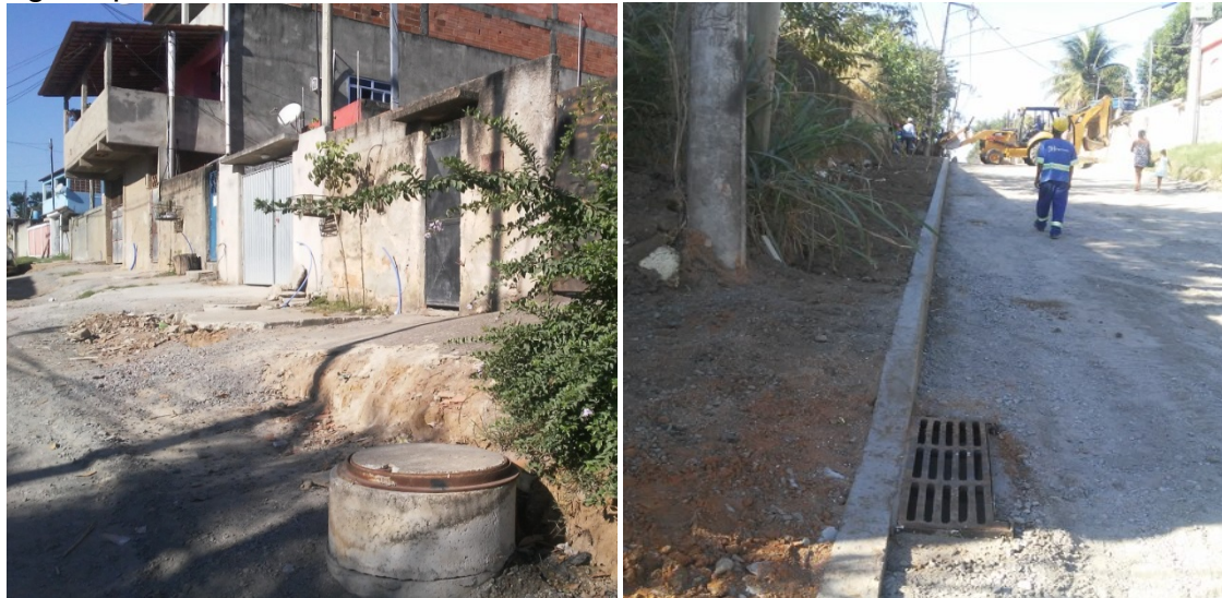
Figuras 46 e 47 - Implantação de rede de esgotamento sanitário e drenagem de águas pluviais - bairro Bom Retiro, ano de 2019.
