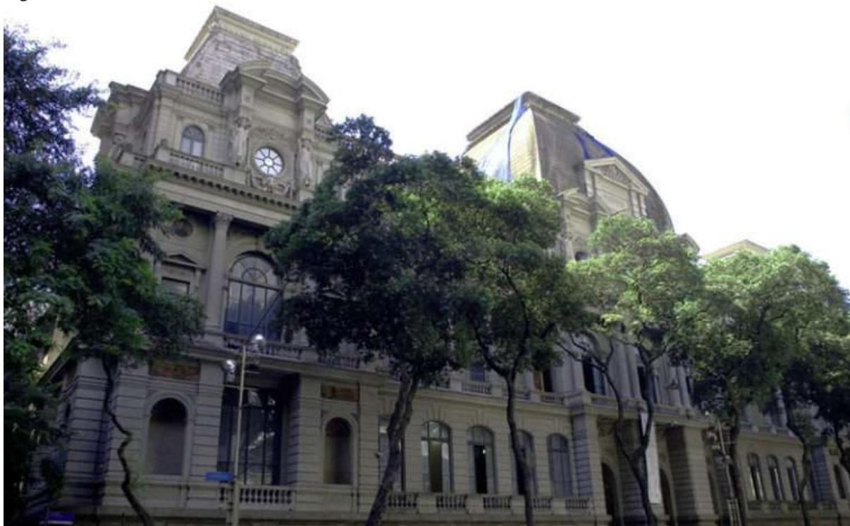
Legenda: Fachada do MNBA/RJ. Fonte: IBRAM.
