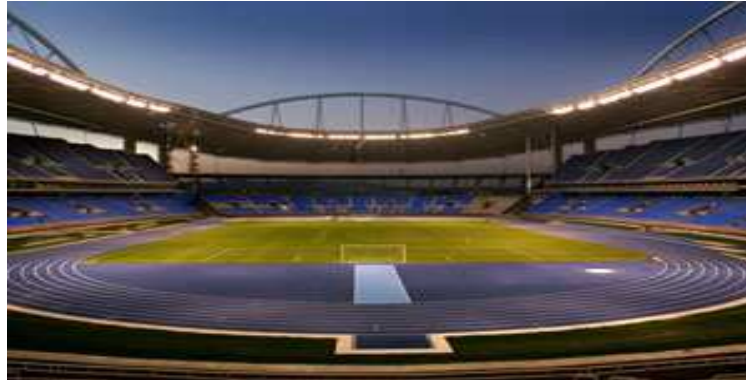
Figura 17 – Estádio Olímpico João Havelange – vista interna
