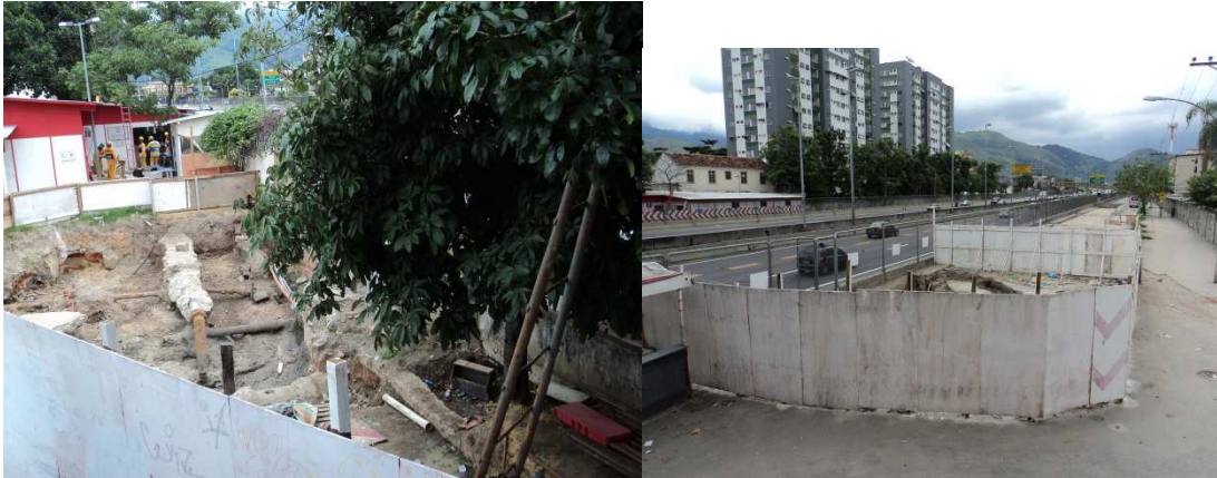
Figura 34 – Canteiro de obras do viaduto da Abolição
