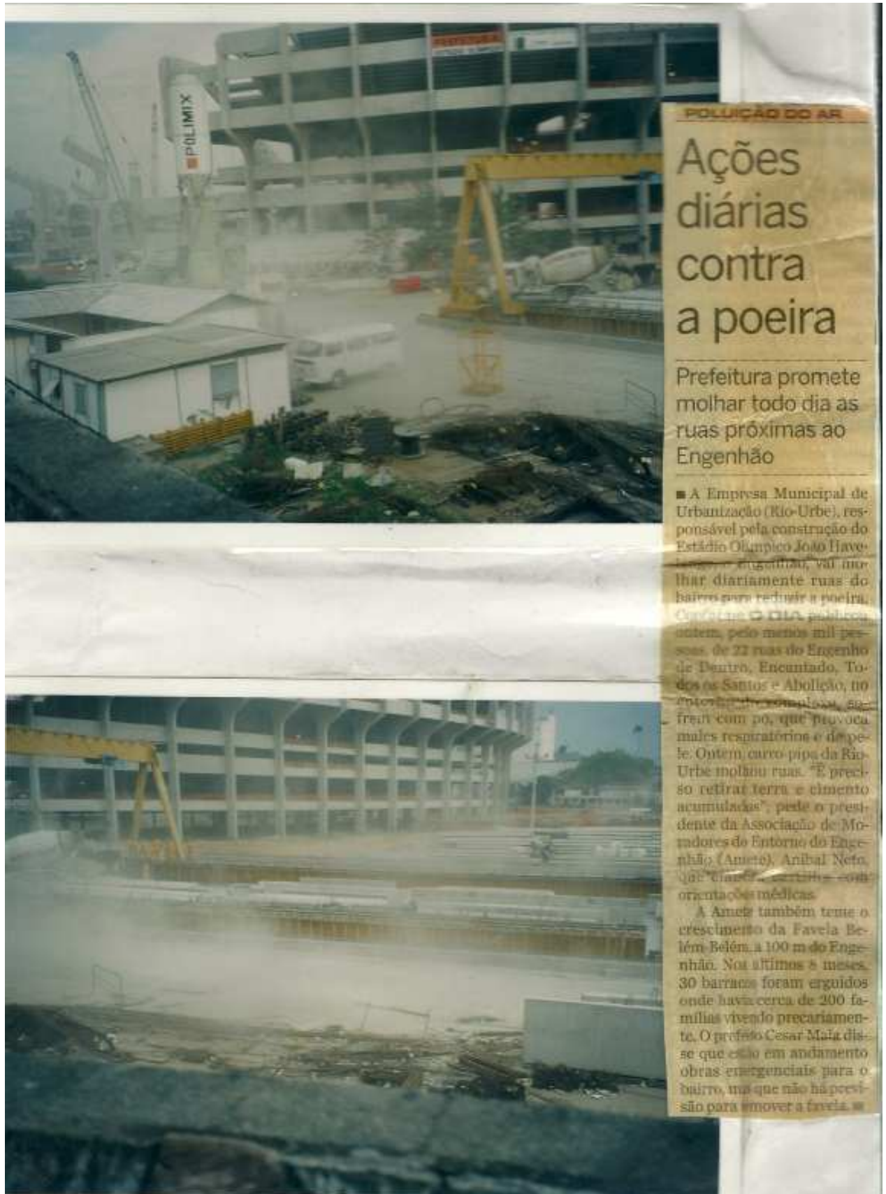
Figura 31 – Obras do Engenheiro
