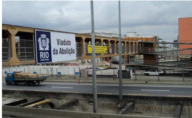
Figura 32 – Linha amarela – área onde será construído o viaduto
