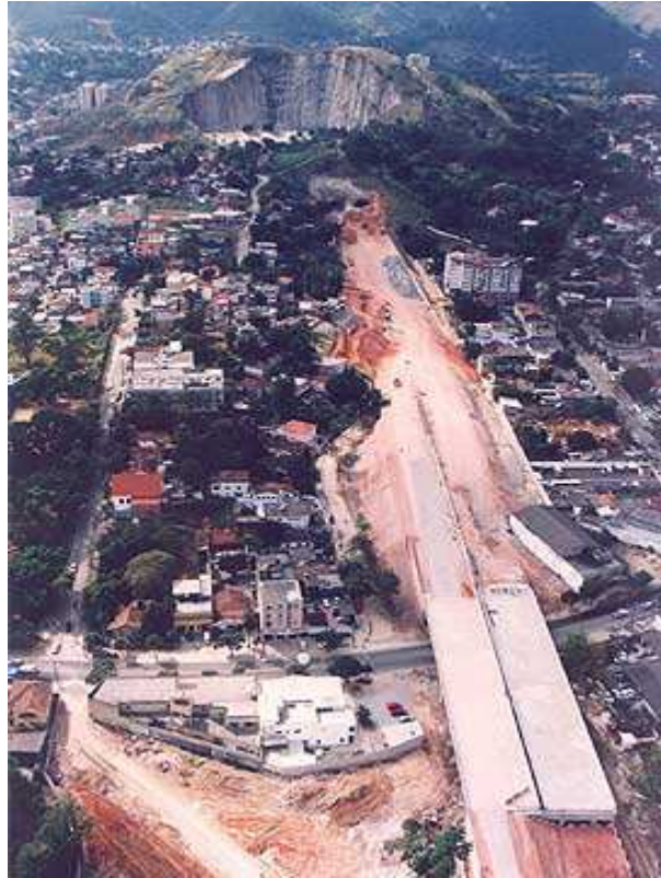
Figura 12 – Linha Amarela durante as obras
