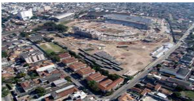
Figura 18 – Estádio Olímpico João Havelange – obras em andamento
