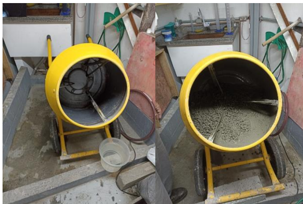
Figura 11 – Processo de homogeneização com emprego de betoneira
