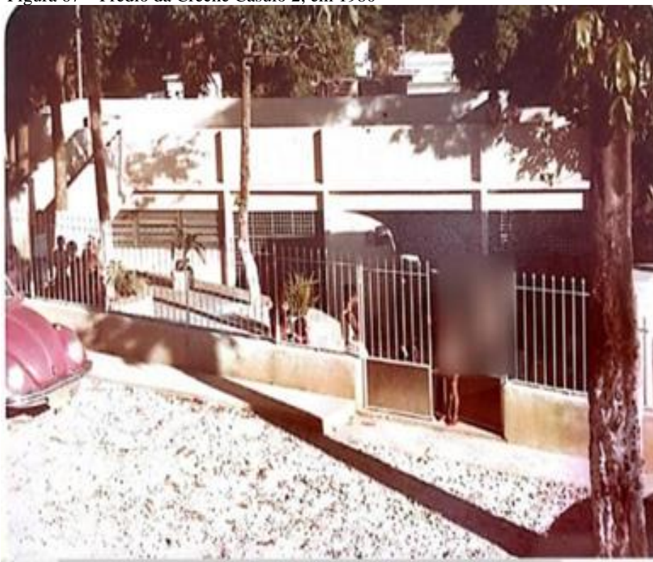
Figura 67 – Prédio da Creche Casulo 2, em 1980
