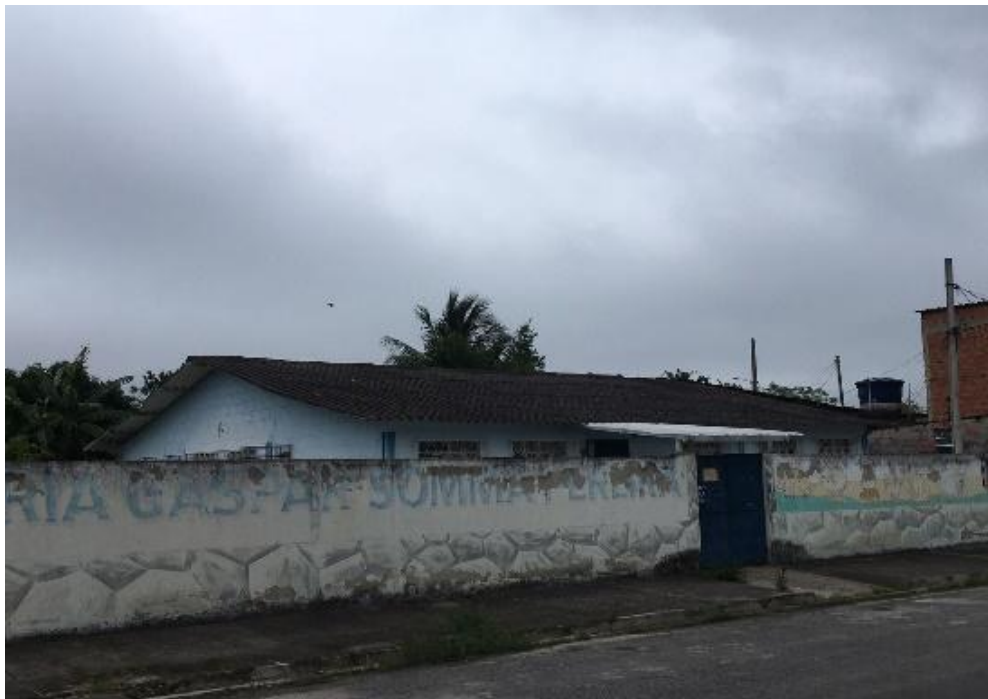
Figura 94 – Prédio da EMEI Patrícia Maria Gaspar Summa Pereira, em 27 de outubro de 2021
