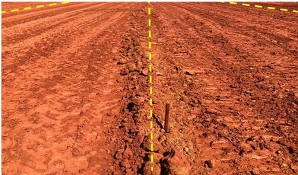
**Figura 45 – Comparação entre a compactação com rolo (porção esquerda) e com trator esteira (porção direita)**
