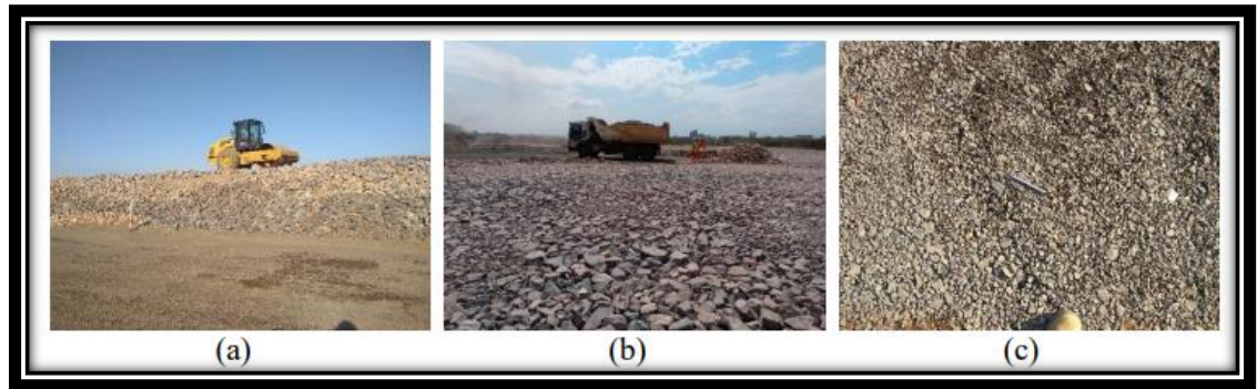
Figura 24 - Execução das camadas para a Pista de Pouso e Decolagem – PPD Execução das camadas do aterro. a) camada de rachão; b) vista superior da camada de rachão; c) camada de BGS executada. (Ávila, 2021).
