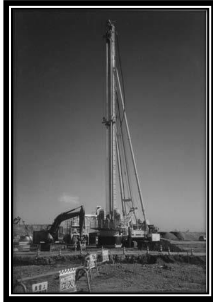
Figura 7 – Equipamento para execução das colunas pelo método seco – DJM.
