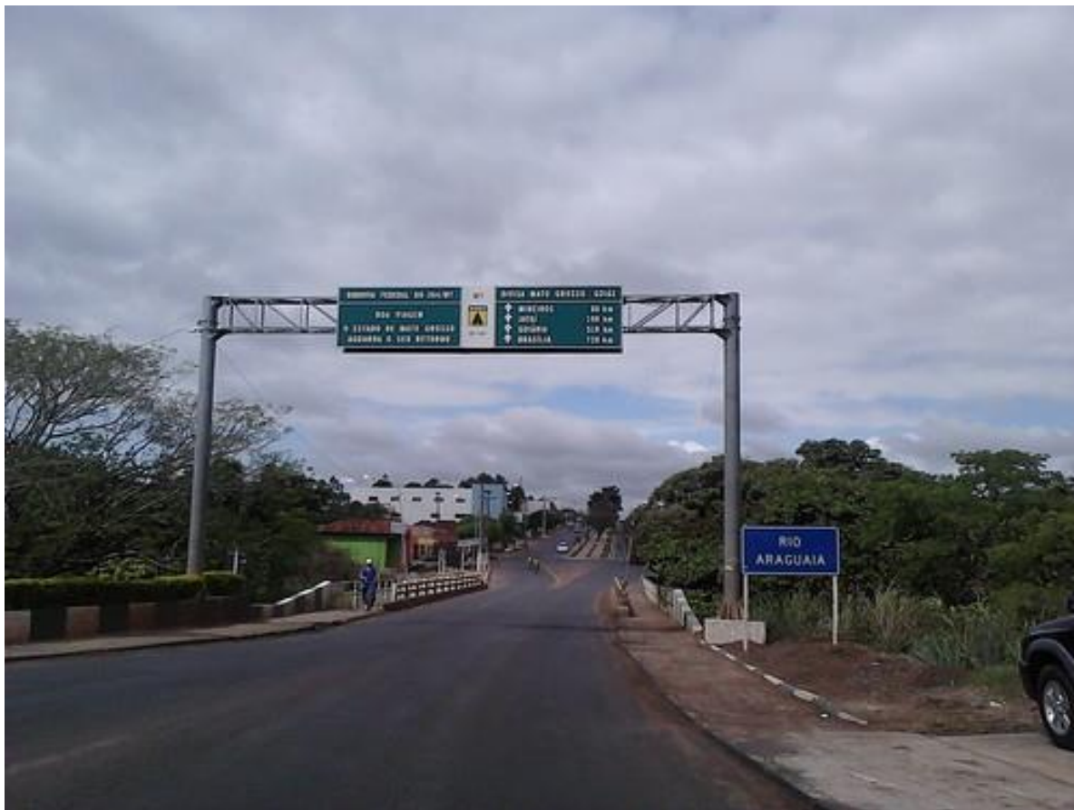
Figura 37 - Ponte sobre o Rio Araguaia e limite entre Alto Araguaia-MT e Santa Rita do Araguaia-MT
