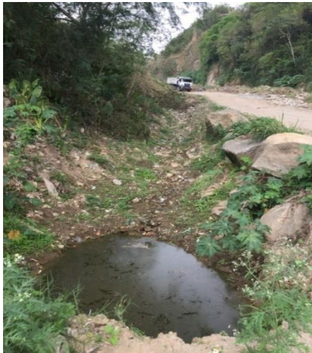
Figura 19 – Ponto de percolação de chorume (PERCOLAÇÃO 02) na parte de baixo do antigo lixão de Mangaratiba
