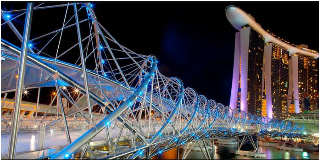
Figura 6 – Ponte Helix, Singapura [9]
