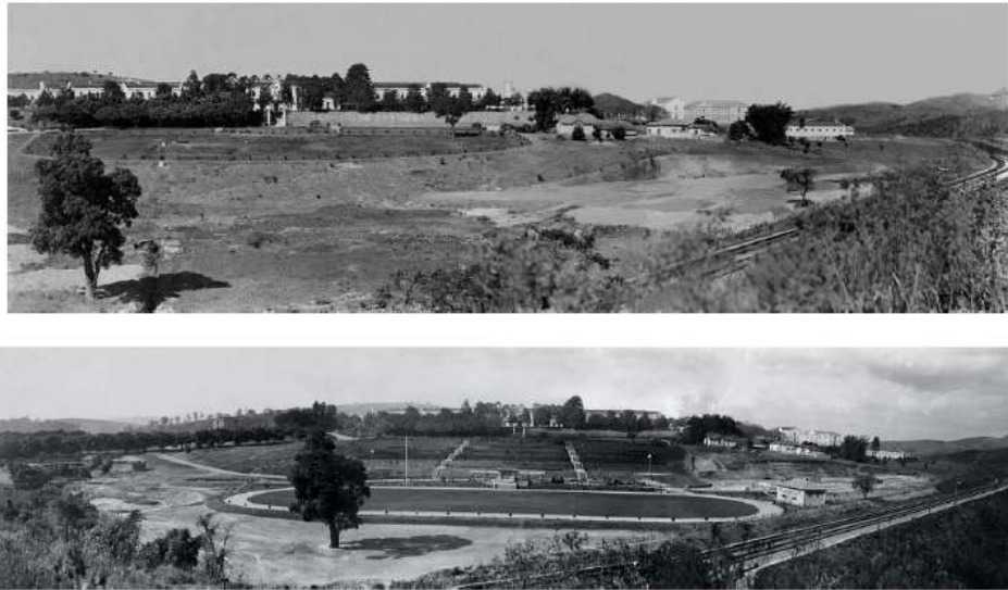
Figura 7. Antes e depois da construção da Praça de Esportes do Juquery. Fonte: Pizzolato (2008). p. 87.
