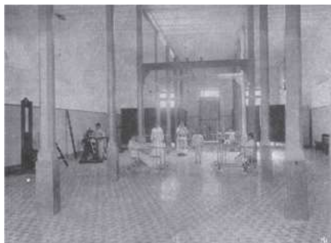
Figura 2. Sala de recreação e recreio do Pavilhão Bourneville/HNA (1904-1905).
